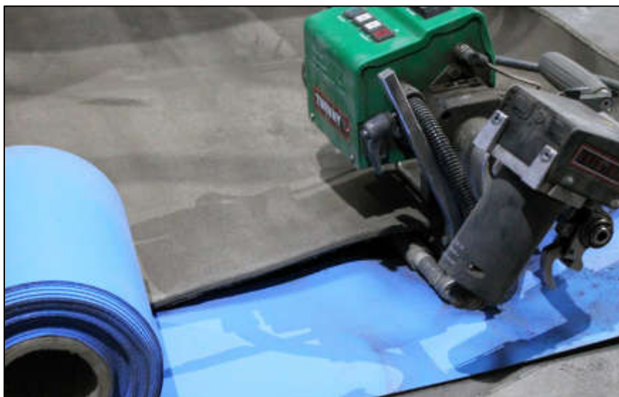
Slika 3.12.8. Varenje pomoću plave trake od 200 mm
