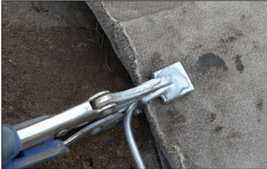
Slika 3.12.5. Ispitivanje zračnog kanala
