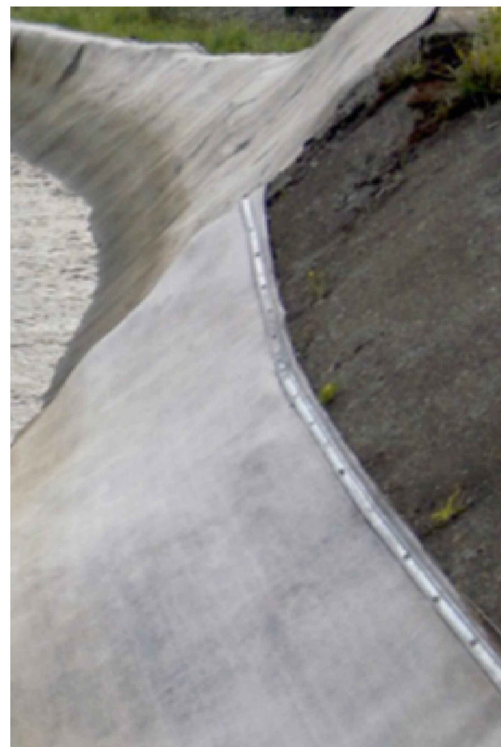
FOTOGRAFIJA PRIMJERA PRIČVRŠĆIVANJA BETONSKOG PLATNA
