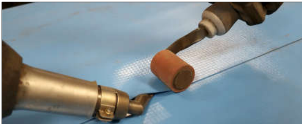
Slika 3.12.6. Sanacija prve staze zavara
