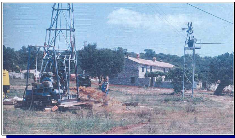
Slika 7.2: Primjer bušenja novog zdenca za navodnjavanje poljoprivredne površine [13]
