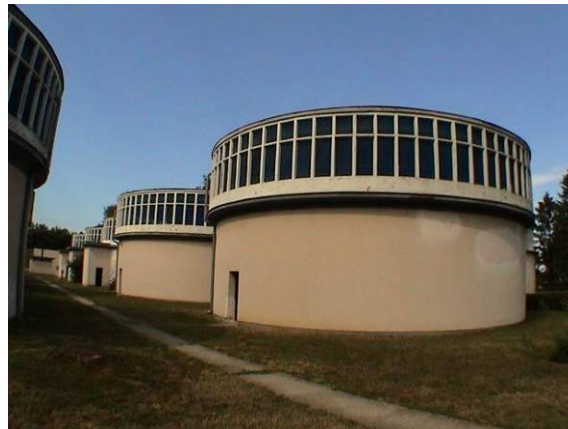
Slika 3/2: Pogon Vodovoda Osijek – taložnici
