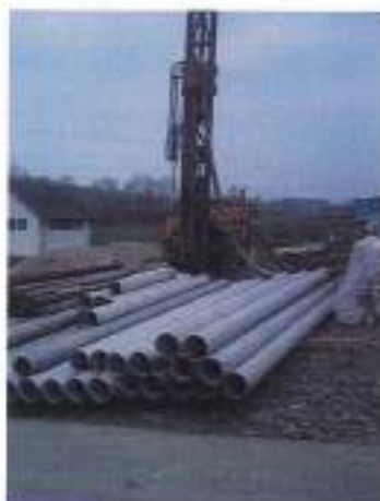
SLIKA 3.2.3.3. Bušenje zdenca ČB-3A na vodočrpilištu "Milaševac" u ožujku 2009. god.
