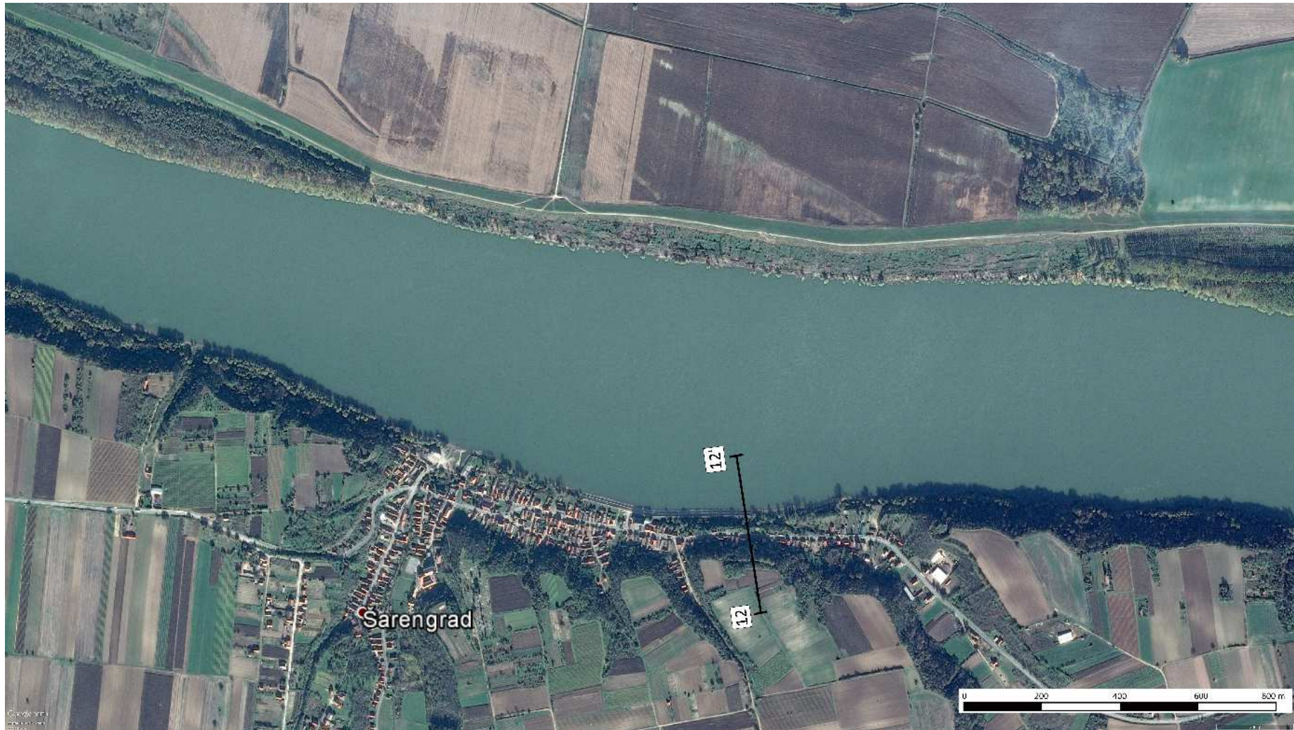
Slika 69. Dobar primjer erozije strmca u Šarengradu. Erozijskim djelovanjem Dunava, strmec je značajno oštećen.
