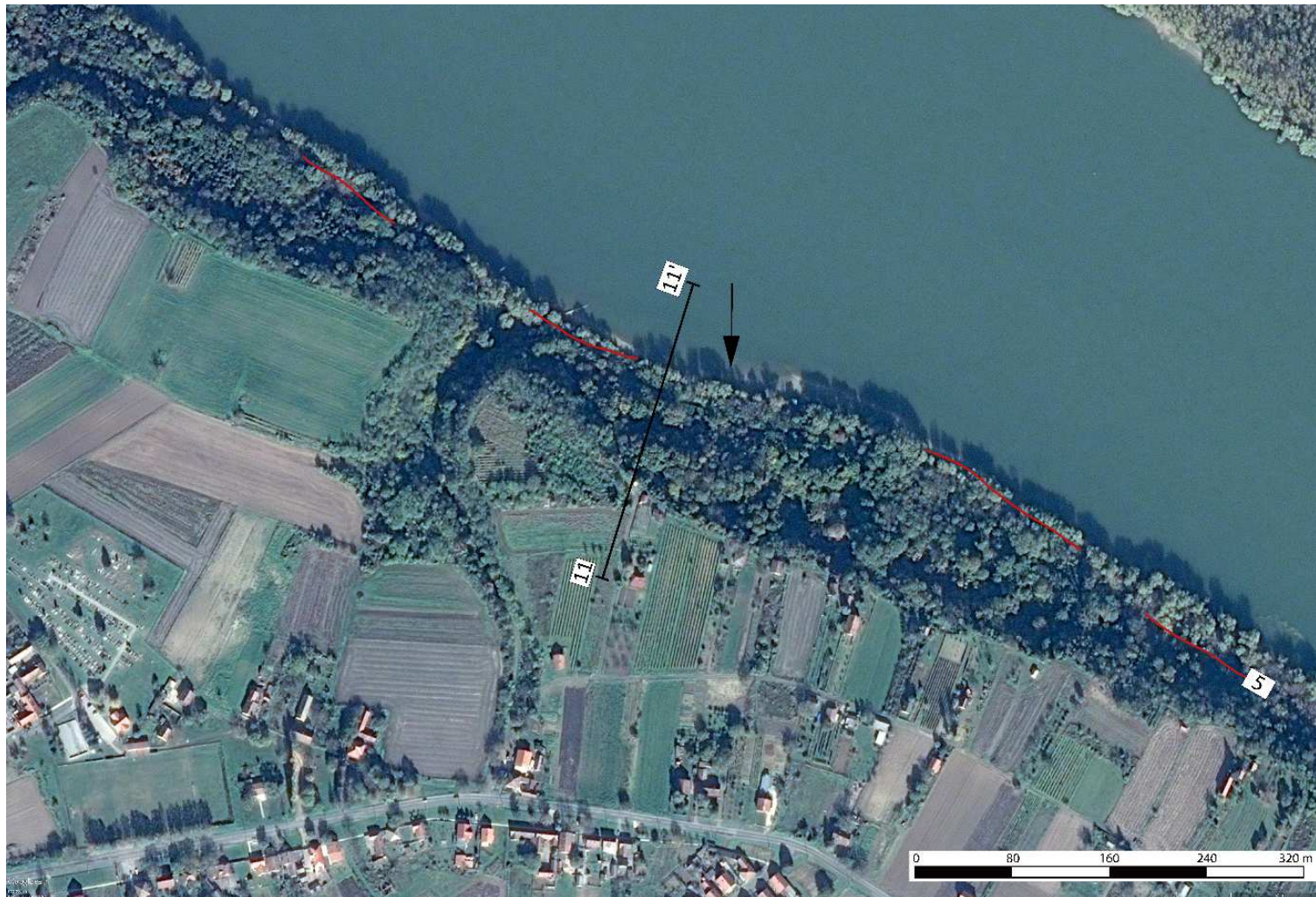
Slika 67. Izravna erozija Dunava prepoznatljiva je po usijecanju obale u strmac i pružanju rasjeda neposredno paralelno obali. U snimci rasjed ostavlja crni trag u podnožju strmca.
