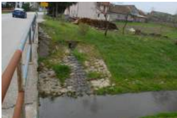
Foto 6. Most na Lomnici. Ušće potoka Kukuljnjak u Lomnicu na ulazu u selo Grančani. Lokalna kanalizacija završava u vodotoku.
