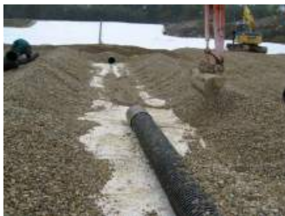
Foto 16. Ugradnja drenažnih cijevi za prikupljanje procjednih voda iz odlagališta Mrcalinska Dubrava.
