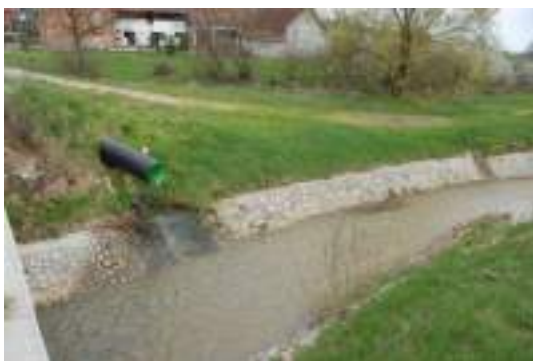
Foto 23. Odvod lokalne kanalizacije u vodotok Mala Buna u istoimenom naselju.
