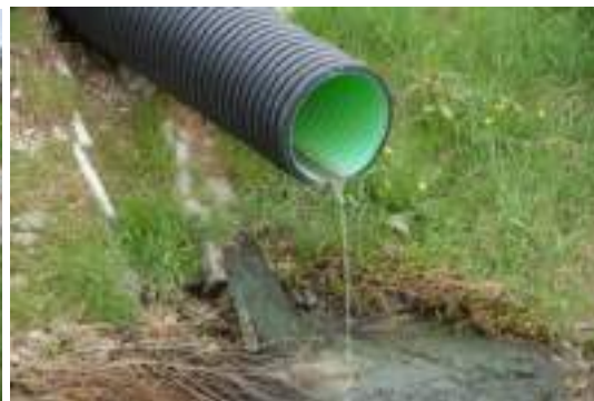
Foto 24. (detalj) Odvod lokalne kanalizacije u vodotok Mala Buna u istoimenom naselju.
