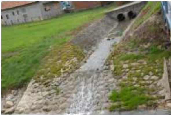
Foto 7. Uređeno korito Kukuljnjaka u Grančanima. Lokalna kanalizacijska mreža završava u vodotoku.
