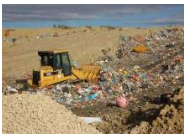
Foto 18. Zbijanje otpada i prekrivanje internim materijalom na odlagalištu otpada Mrcalinska Dubrava.
