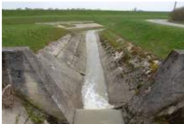
Foto 12. Ušće potoka Rameščaka u Lomnicu. Obala potoka uređena betonom.
