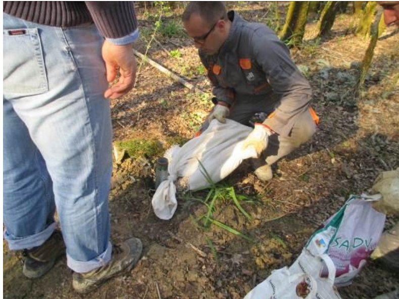
Slika 30. Postavljanje filtarskog zasipa
