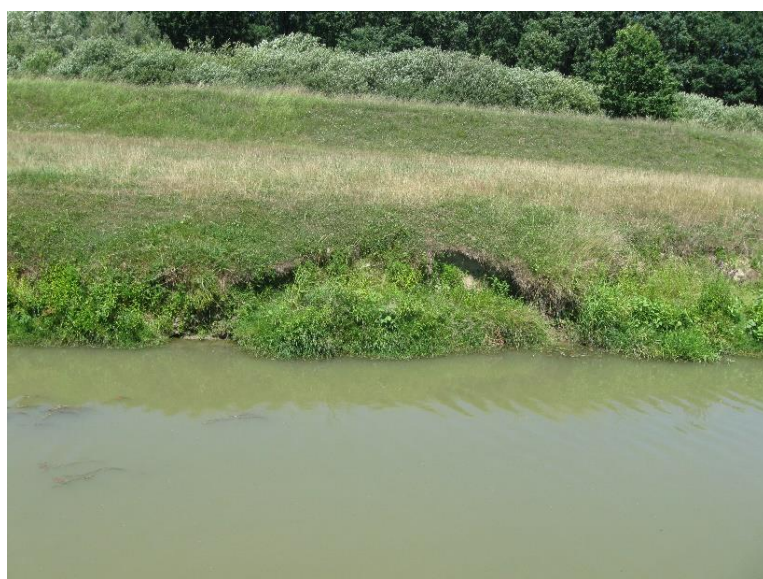
Slika 1b: - erozija obala
