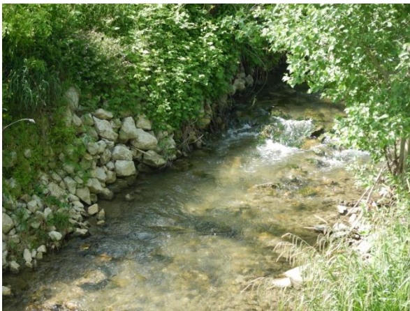
Slika 1c: Obala na odsječku je utvrđena kamenim nabačajem ili betonskim zidovima
