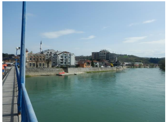
Slika 1b: Na BIH strani obala je betonirana zidom visine 5 metara
