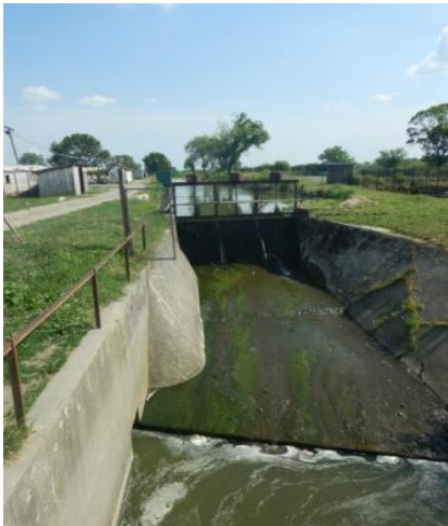
Slika 1a: Ustava za ribnjake na lokaciji monitoringa
