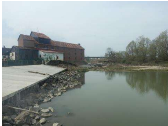
Slika 2.27b: Orljava – građevine unutar korita
