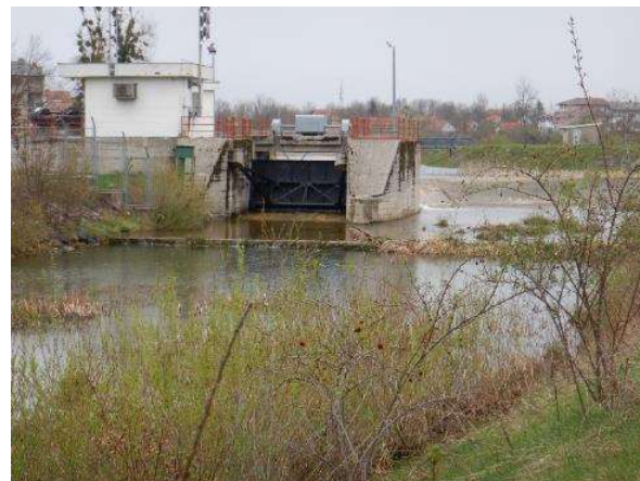
Slika 2.45b: Otuča – hidrotehničke građevine u koritu
