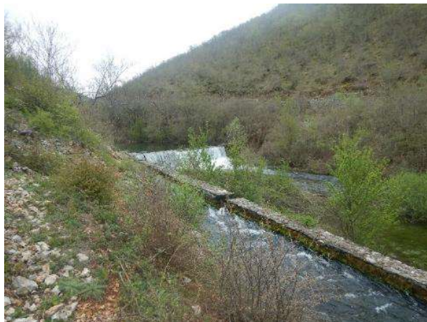
Slika 2.41b: Krčić – Riparijska zona i građevine u koritu
