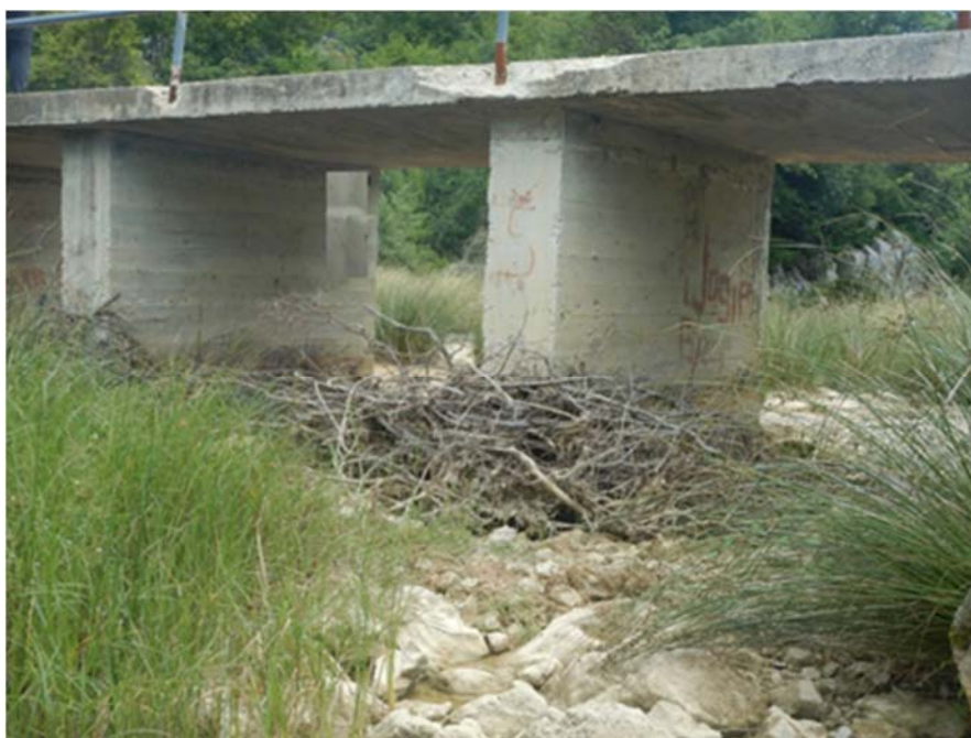
Slika 5.1.1. Baščica, uzvodno od Posedarja.
