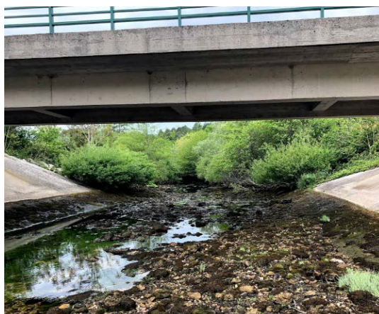
Slika 4.7. Odvodni kanal HE Golubić, prije utoka u Butižnicu – jedna od referentnih postaja 4. grupe. Na ovoj postaji uzorkovanje je provedeno u suradnji s HEP-ovim djelatnicima te je privremeno zaustavljen rad hidroelektrane HE Golubić.
