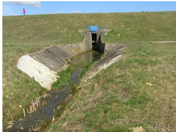
Slika 53.1d: Lateralni kanal, Slakovec – brana Jegerseg i temeljni ispust (početak vodnog tijela)
