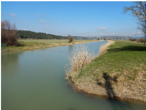
Slika 43.1a: Obuhvatni kanal br. 1, Grandini – prиток kanala u korito
