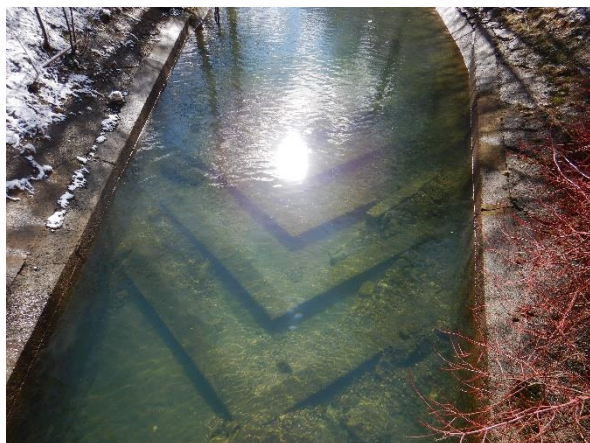
Slika 20.1c: Ličanka, ispod CHE Fužine – usporivači energije (zupci) u koritu
