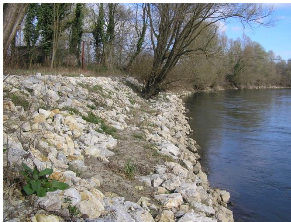
Slika 59.1b: Mura, prije utoka u Dravu – početak odsječka, obaloutvrda od kamenog nabačaja na obali
