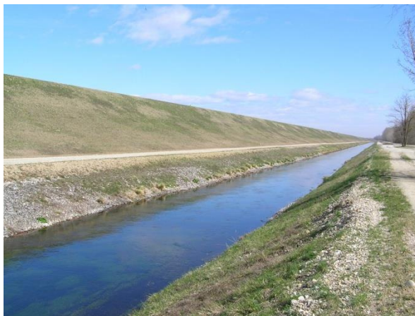
Slika 61.1a: Obodni kanal (desni drenažni) HE Dubrava, Dubovac – početak odsječka pogled s desne obale prema nizvodno
