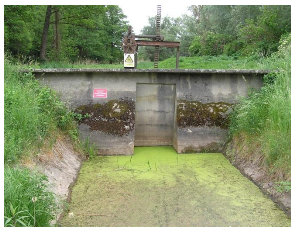
Slika 111.1d: Miškaruš, Malo Gačišće – ustava na vodnom tijelu nizvodno od promatranog odsječka
