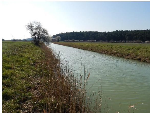
Slika 43.1b: Obuhvatni kanal br. 1, Grandini – uzvodni dio kanala i zaobalje
