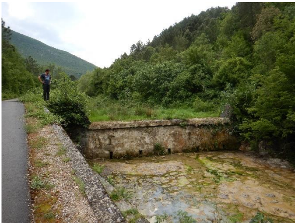
Slika 77.1c: Zvizda, gornji tok – sedimentna brana uzvodno od odsječka
