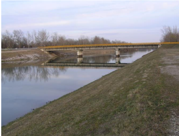
Slika 57.1a: Odvodni kanal HE Čakovec, Otok – početak odsječka i pogled nizvodno
