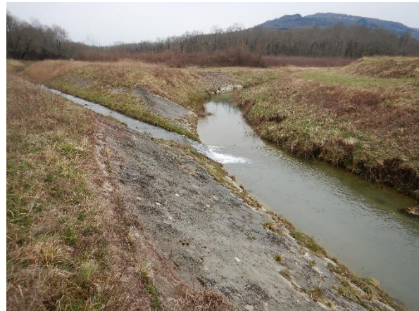
Slika 42.1b: Odvodno preljevni kanal Botonege, Senjska vala – utvrđenost obale, desni pritok i trag erozijskog djelovanja
