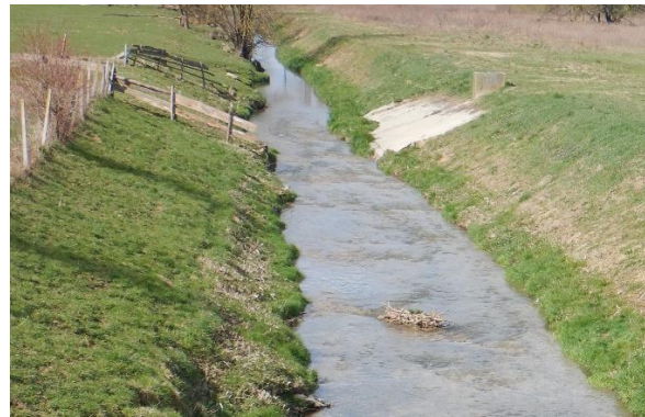
Slika 66.1d: Toplica, nizv. Daruvar, betonirano korito
