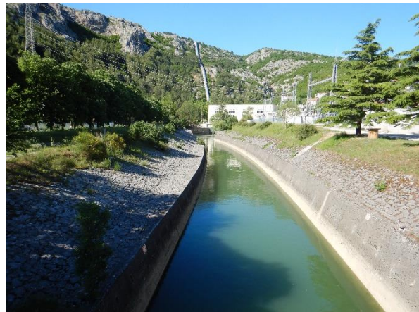
Slika 79.1d: Odvodni kanal, HE Orlovac – obale i riparijska zona
