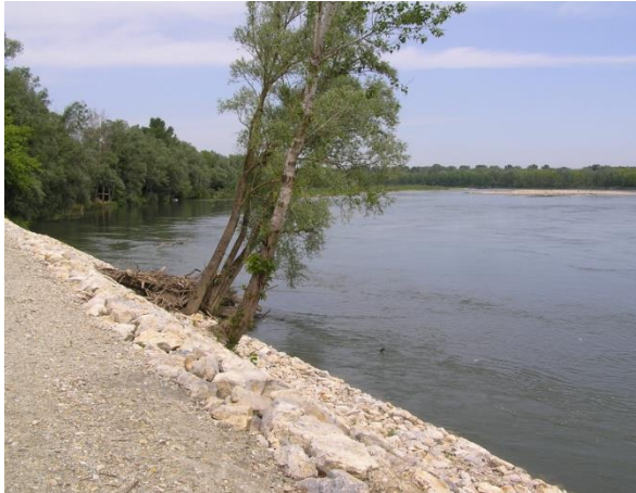
Slika 107.1a: Drava, Štorgač – početak odsječka, detalj obaloutvrde i pogled uzvodno
