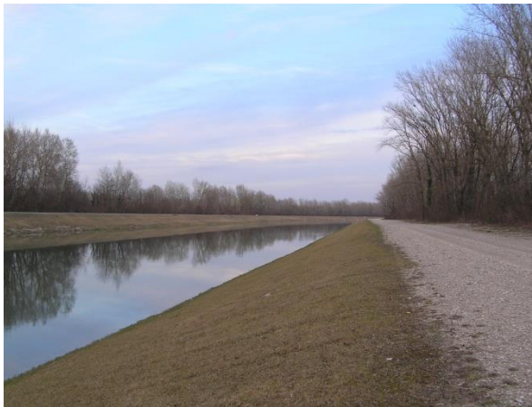
Slika 57.1c: Odvodni kanal HE Čakovec, Otok – sredina odsječka i pogled nizvodno
