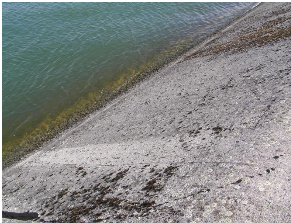
Slika 60.1c: Dovodni kanal HE Dubrava, HE Dubrava – detalj obloge pokosa kanala
