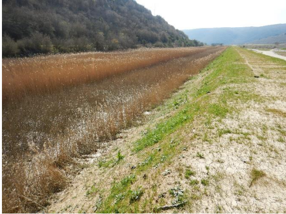
Slika 35.1a: Obuhvatni kanal Krapanj, prije ušća u Rašu – riparijska zona i zaobalje
