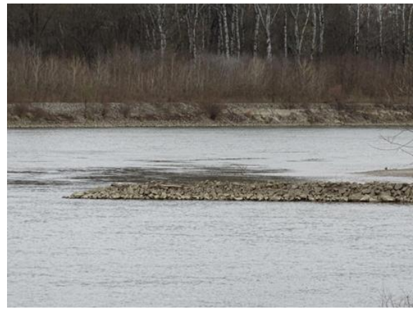
Slika 74.1d: Drava, Petrijevci – utvrđene obale s lijeve strane rijeke i pero na nizvodnoj dionici odsječka
