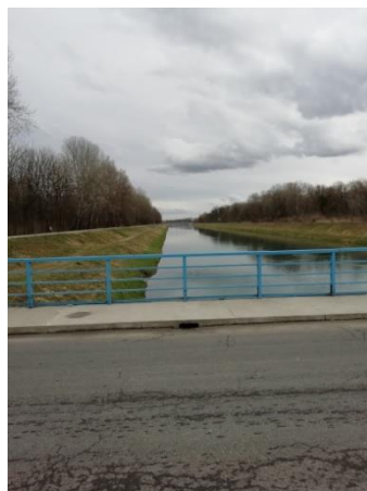
Slika 51.1a: Odvodni kanal HE Varaždin, Varaždin početak odsječka, pogled nizvodno
