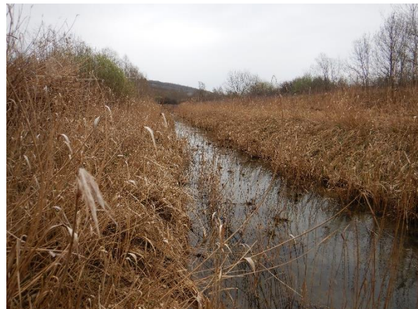
Slika 33.1b: Obuhvatni kanal Bastija, Ponte Porton – obale i riparijska zona
