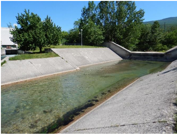
Slika 83.1c: Odvodni kanal HE Golubić, prije utoka u Butižnicu – uzvodni pritok i stepenica
