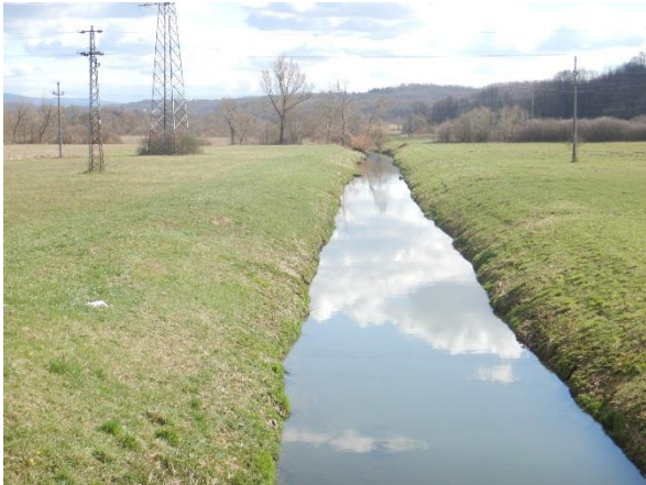
Slika 66.1a: Toplica, nizv. Daruvara – obale i vodotok
