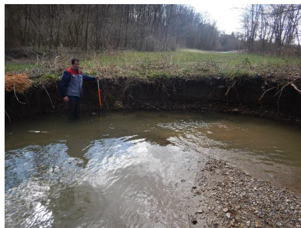
Slika 65.1d: Toplica, uzv. Daruvara, erozija obale
