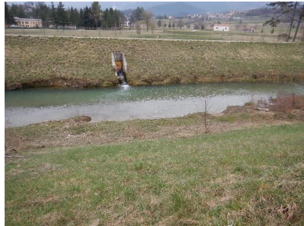
Slika 36.1b: Mirna, uzv. od Buzeta, kod Istarskog vodovoda – obale, odvodni ispust i tragovi erozije
