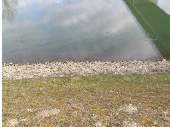
Slika 58.1b: Odvodni kanal HE Dubrava, D. Vidovec – detalj strukture obale i nožice pokosa
