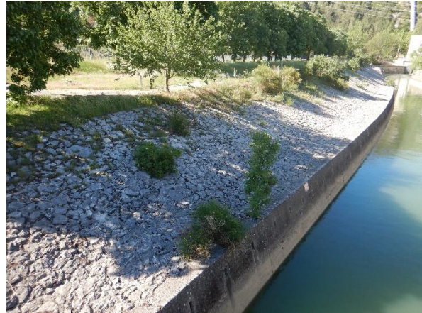
Slika 79.1b: Odvodni kanal, HE Orlovac – utvrđenost obale
