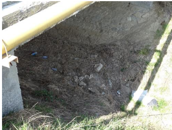
Slika 70.1d: Stari Travnik – isušeno riječno korito na lokaciji mosta i pjeskovit sediment na dnu
