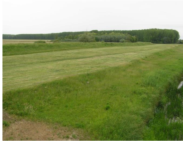
Slika 112.1b: Županijski kanal, Kapinci – lijevi nasip
