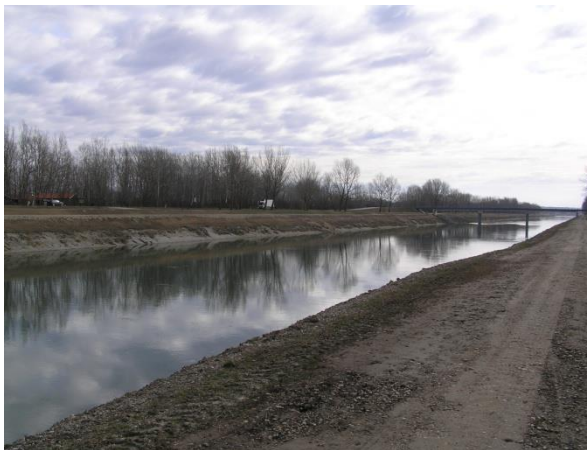
Slika 58.1c: Odvodni kanal HE Dubrava, D. Vidovec – sredina odsječka, pogled s desne obale na kanal nizvodno
