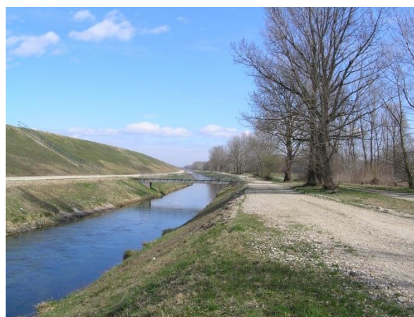
Slika 61.1d: Obodni kanal (desni drenažni) HE Dubrava, Dubovac – kraj odsječka, pogled nizvodno
