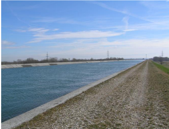
Slika 60.1a: Dovodni kanal HE Dubrava, HE Dubrava – pogled na kanal s desnog nasipa prema nizvodno
