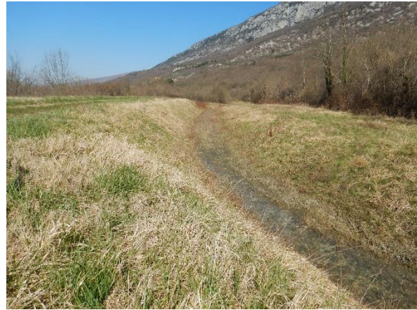
Slika 45.1b: Obuhvatni kanal br. 3, Belići – obale, riparijska zona i zaobalje
