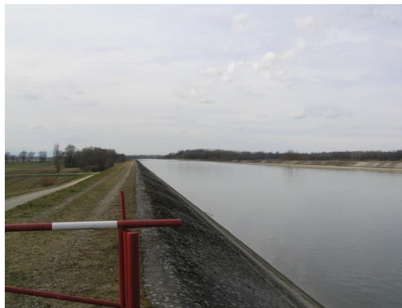
Slika 55.1b: Dovodni kanal HE Varaždin, Petrijane početak odsječka, pogled uzvodno
