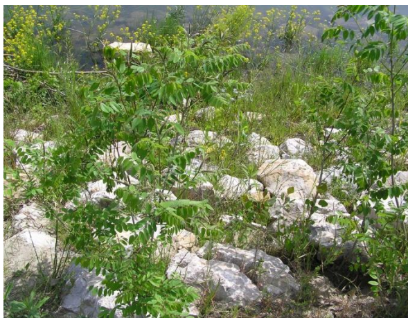
Slika 106.1a: Drava, Ledine Molvanske – odsječak nizvodno, detalj obaloutvrde od kamenog nabačaja
