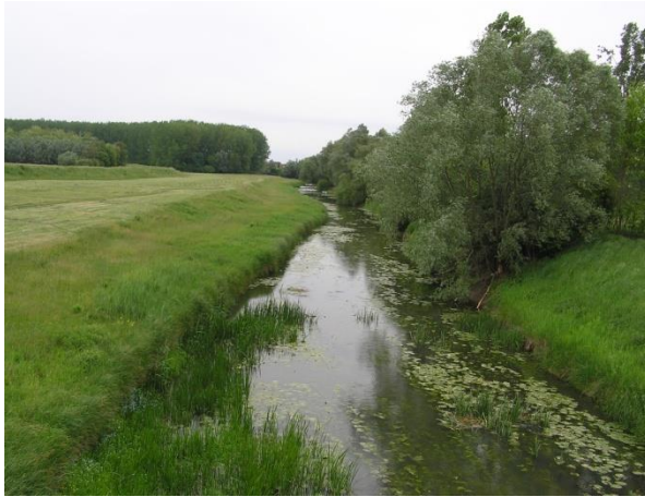
Slika 112.1a: Županijski kanal, Kapinci – pogled nizvodno na kanal
