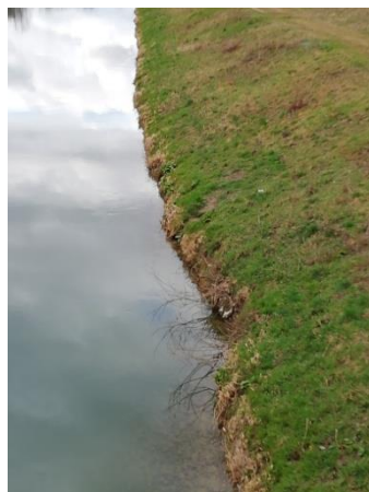
Slika 51.1c: Odvodni kanal HE Varaždin, Varaždin detalj riparijske zone
