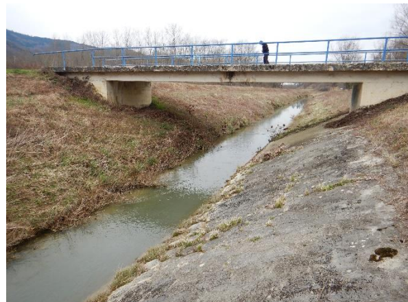
Slika 42.1d: Odvodno preljevni kanal Botonege, Senjska vala – obale i riparijska zona
