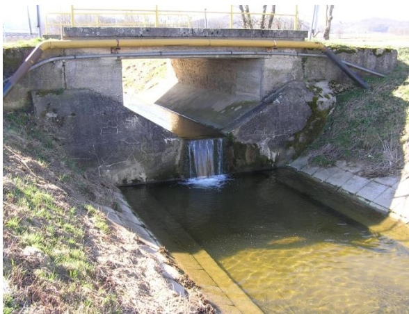
Slika 52.1a: Stara Mura, cesta između Sv. Martina na Muri i Murskog – nizvodno od početka odsječka, preliv s taložnicom
