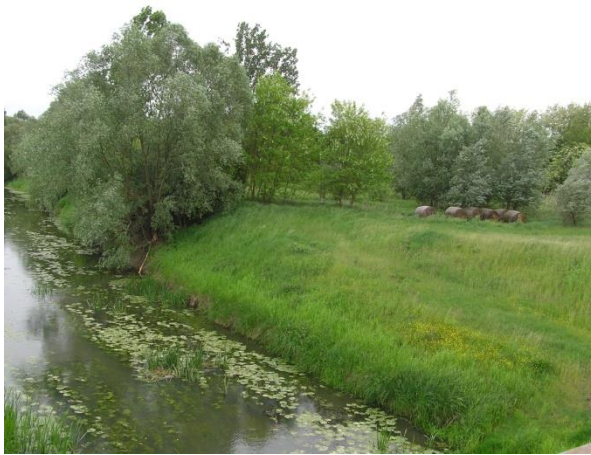
Slika 112.1c: Županijski kanal, Kapinci – pogled na desnu obalu
