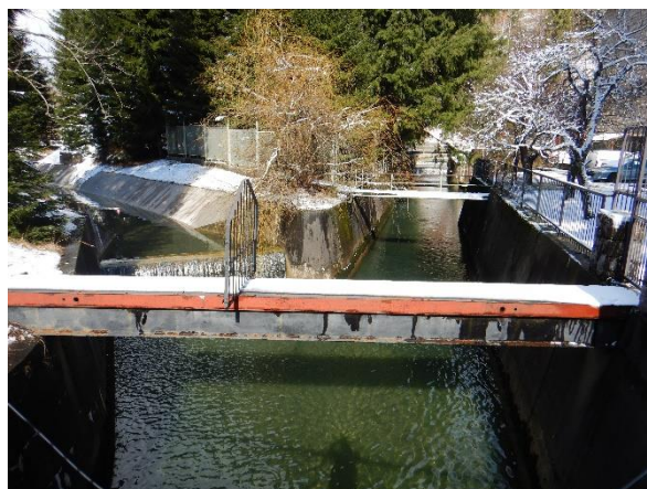
Slika 20.1b: Ličanka, ispod CHE Fužine – Ličanka i desni pritok kanala Kostanjevica
