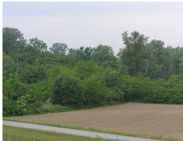
Slika 105.1d: Dovodni kanal HE Čakovec, HE Čakovec –korištenje zemljišta iza lijevog nasipa
