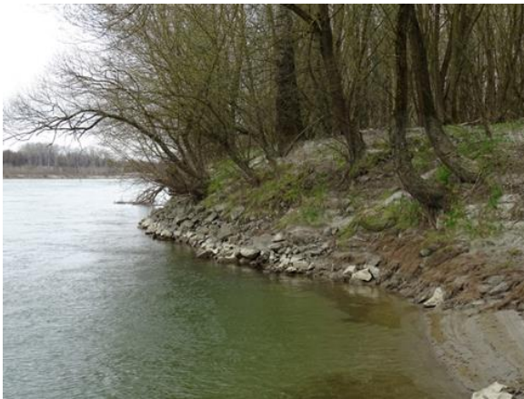
Slika 74.1c: Drava, Petrijevci – utvrđene obale s desne strane rijeke
