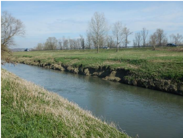
Slika 15.1c: Krapina, S. Slatina - Erozijska obala na odsječku
