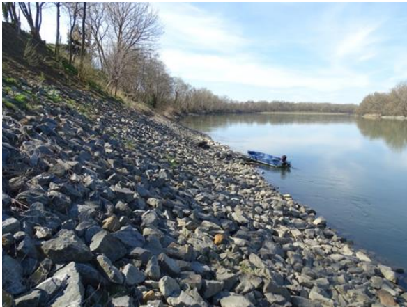
Slika 72.1c: Drava, Bistrinci – pokos obale i učvršćivanje desne obale tvrdim umjetnim materijalom
