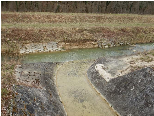
Slika 42.1c: Odvodno preljevni kanal Botonege, Senjska vala – pritok Senice i trag erozijskog djelovanja
