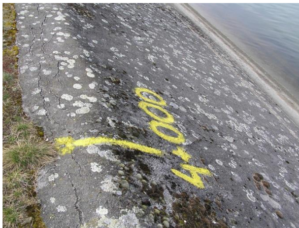
Slika 55.1a: Dovodni kanal HE Varaždin, Petrijane detalj obloge pokosa
