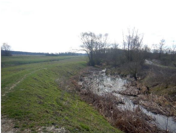
Slika 62.1a: Lateralni kanal – obale i vodotok, vodotok
