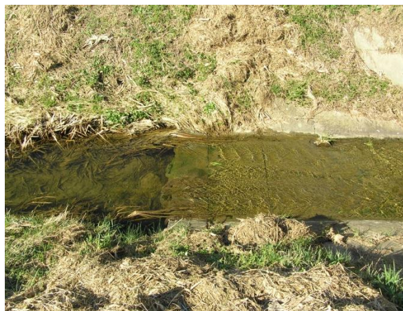
Slika 52.1b: Stara Mura, cesta između Sv. Martina na Muri i Murskog – početak odsječka, trapezni betonirani p.p. preljeva
