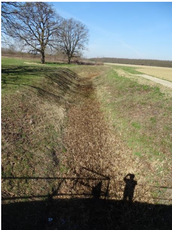
Slika 68.1a: Strug– nizvodna dionica odsječka: vodno tijelo, riparijska zona i zaobalje
