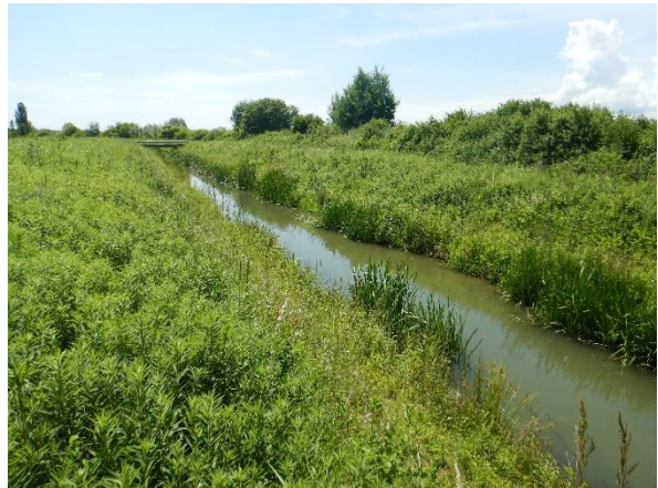
Slika 115.1d: Nova Rijeka, most na cesti Staro Obradovci - Zokov Gaj
