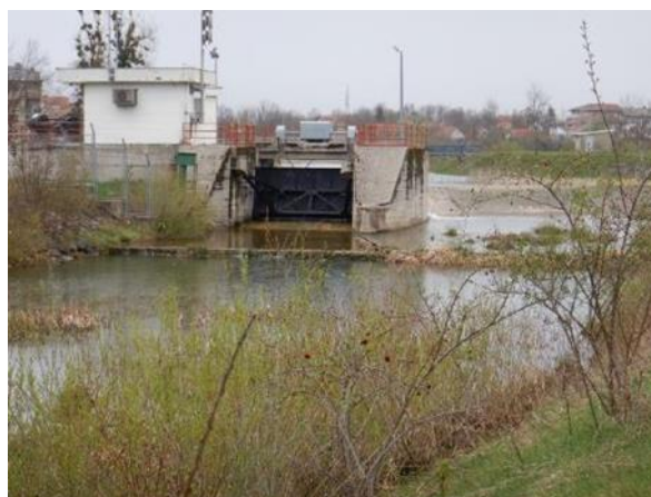
Slika 85.1b: Otuča – hidrotehničke građevine u koritu
