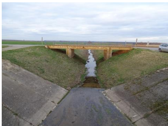
Slika 19.1d: Vuka, na cesti Krndija – betonirani pokos i dno
