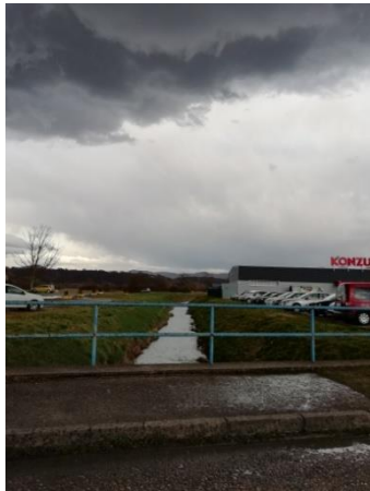
Slika 13.1a: Korušćak, Novi Marof - pogled nizvodno od početka odsječka – ravna regulacijska linija
