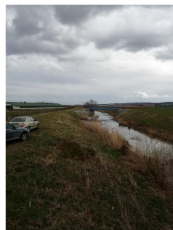
Slika 11.1d: Plitvica, most kod Kućana Gornjeg – pogled na korito nizvodno od mosta
