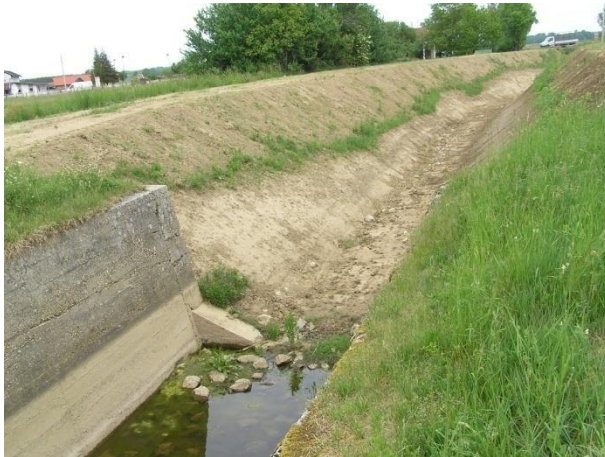
Slika 90.1a: Suha Katalena, cesta Đurđevac-Kloštar Podravski – regulacija korita nizvodno od betonske stepenice s taložnicom
