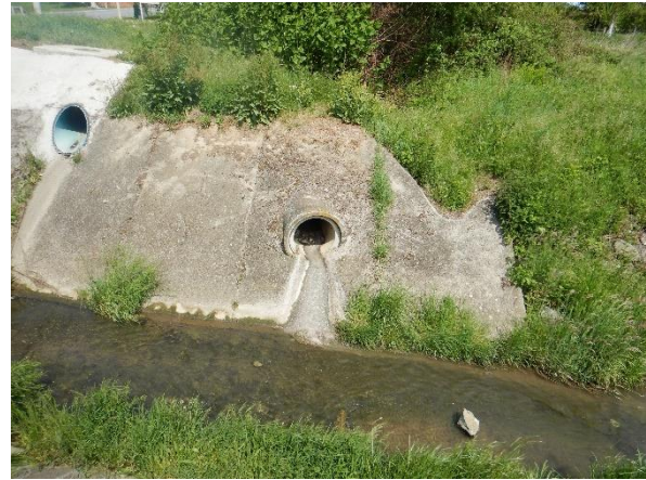
Slika 29.1b: Kaptolka, Eminovci – ispust oborinskih voda
