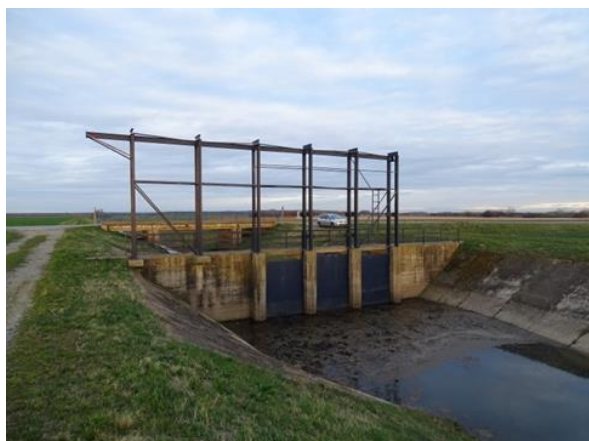
Slika 19.1c: Vuka, na cesti Krndija – umjetna građevina (ustava) u sredini dionice koja u potpunosti mijenja prirodni tok rijeka i migraciju riba
