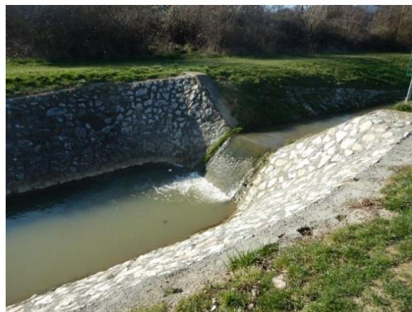
Slika 5.1d: Potok Štefanovec - stube i utvrđenost obala
