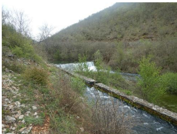
Slika 81.1b: Krčić – Riparijska zona i građevine u koritu
