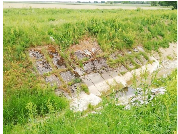
Slika 91.1b: Sirova Katalena, cesta Đurđevac- -Kloštar Podravski – stepenica u koritu
