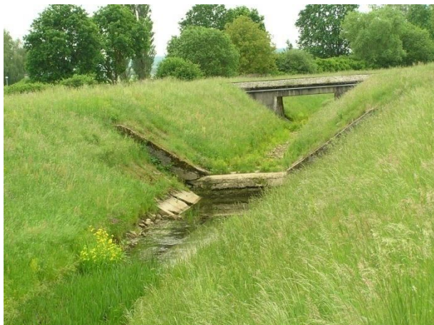
Slika 92.1a: Obuhvatni Đurđevac, Đurđevac – stepenica u koritu
