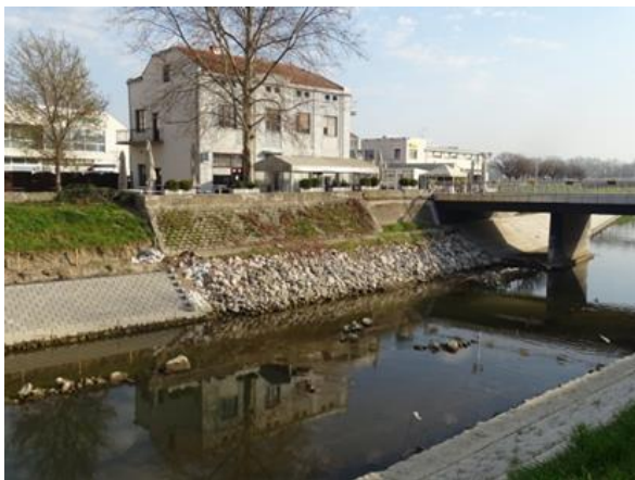
Slika 23.1c: Vuka, Vukovar – betonirani pokos i kameni nabačaj u koritu
