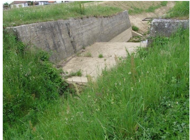
Slika 90.1b: Suha Katalena, cesta Đurđevac-Kloštar Podravski – betonska stepenica s taložnicom
