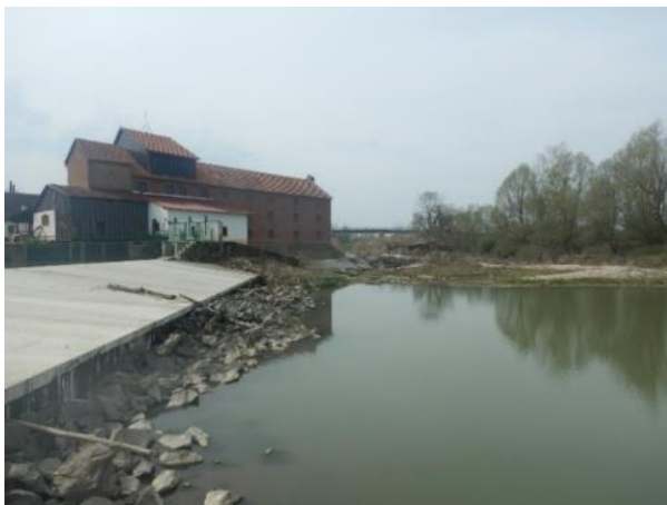
Slika 69.1b: Orljava – građevine unutar korita
