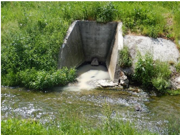
Slika 28.1c: Vrbova, Pleternica – kanalizacijski korito
