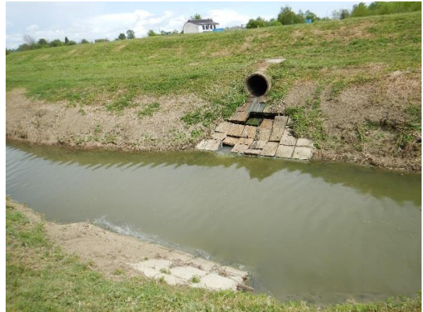
Slika 30.1b: Lonja, nizvodno od Ivanić Grada - ispust
