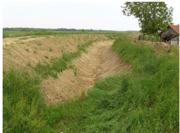
Slika 90.1d: Suha Katalena, cesta Đurđevac-Kloštar Podravski – regulacija korita (vodno tijelo nizvodno od promatranog odsječka)
