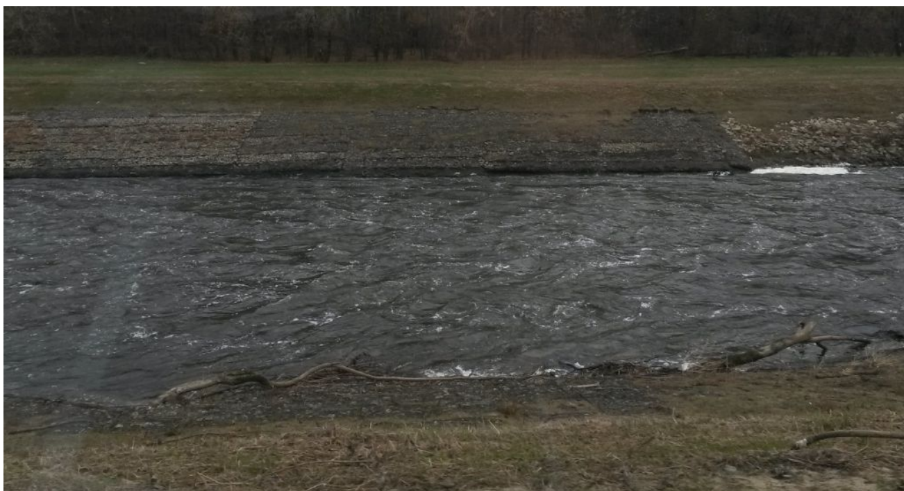
Slika 1-4 Gabionska obloga korita kanala
