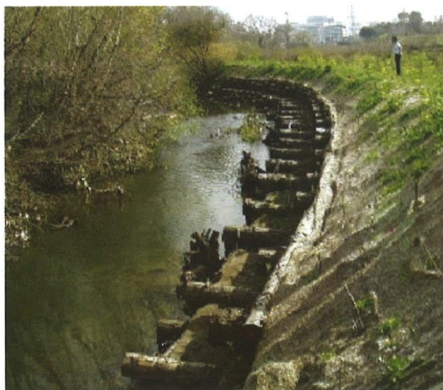
Slika 1.1.3-8: Pogled na dionicu pokosa stabiliziranog drvenim talpama [1]
