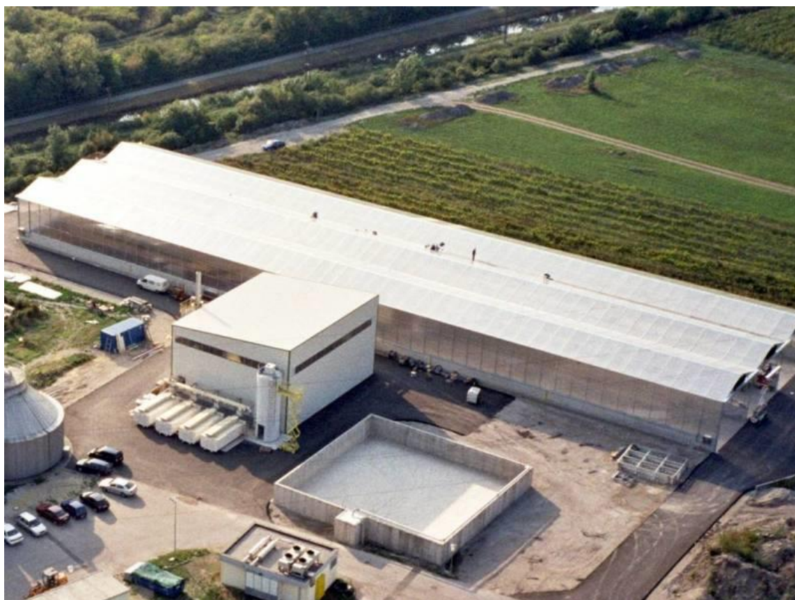
Prilog, Slika 12. Izvedeni pogon za solarno sušenje mulja u kombinaciji sa spalionicom mulja (300.000 ES, Austrija, u pogonu od 2003.)
