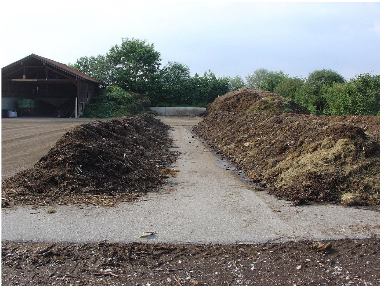
Prilog, Slika 14. Kompostana mulja na otvorenom – windrow sistem ( https://de.wiktionary.org/wiki/Kompostierungsanlage )
