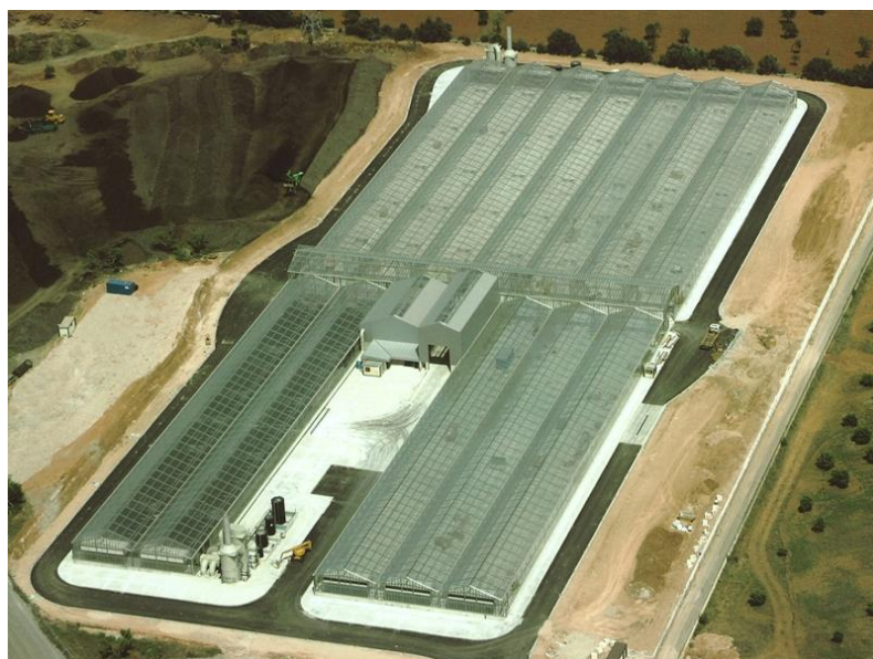
Prilog, Slika 10. Izvedeni pogoni za solarno sušenje mulja (1)
