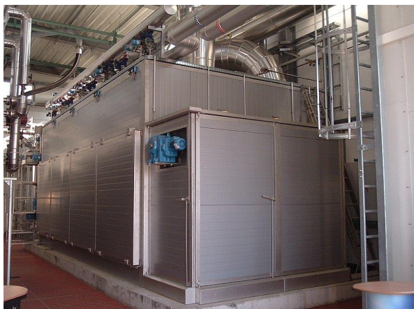
Prilog, Slika 13. Instalirane jedinice za termalno sušenje mulja
