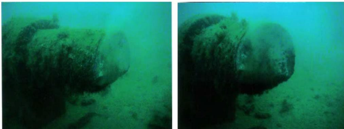
Slika 2-9: Slika s ispustom kroz jednu cijev u Vrsaru gdje se kanalizacija ispušta u more kroz otvor na kraju cijevi na morskom dnu.
