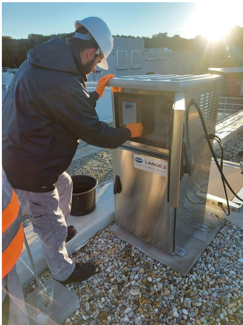
Slika 2. Uzorkivač na lokaciji UPOV-a Vrsar koji je uzorkovao izlaznu obrađenu vodu
