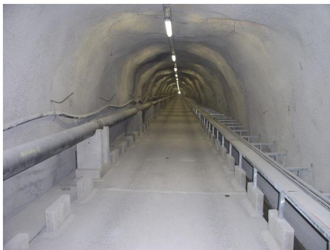
Slika 23: Fotografija uređenog kanalizacijskog tunela „Čiovo“
