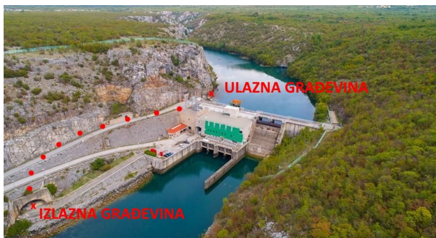
Slika 2: Akumulacija Đale - postojeći obilazni tunel u stijeni
