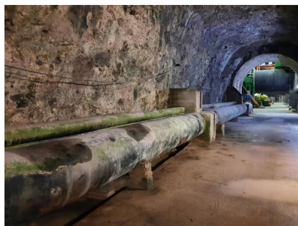
Slika 13: HE Zakučac - servisni tunel za prilaz čvoru vodne i zasunske komore
