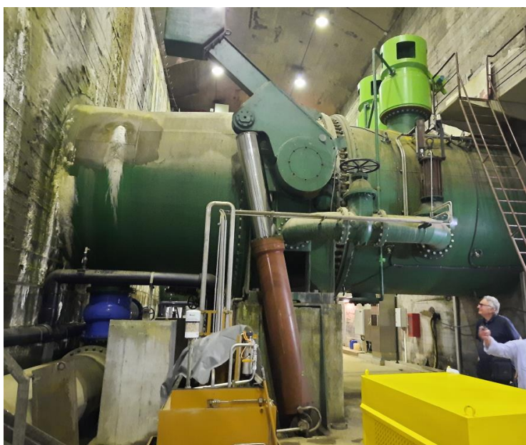
Slika 12: HE Zakučac – zasunska komora, jedna od četiri dovodne cijevi
