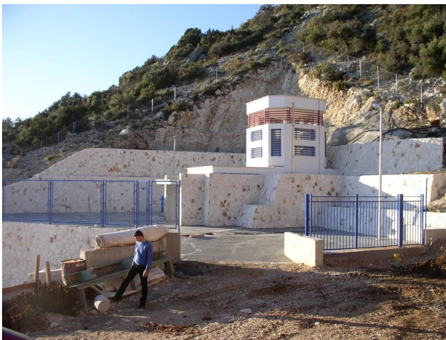
Slika 25: Izlazna portalna građevina hidrotehničkog tunela "Čiovo", oblikovana da djeluje kao "dimnjak"
