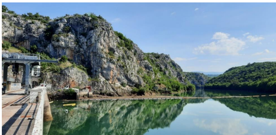
Slika 3: Akumulacija Đale - područje lokacije zahvatne građevine uz akumulaciju
