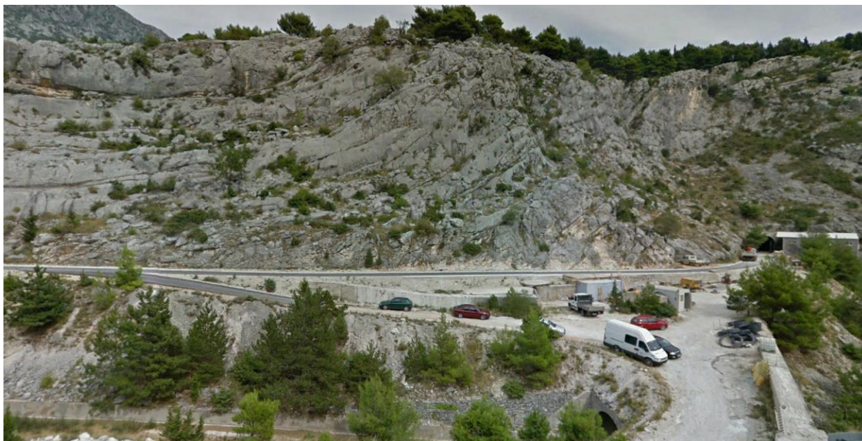
Slika 14: HE Zakučac - postojeći ulaz u tunel i područje lokacije ulazne građevine hidrotehničkog tunela na širem području oko zasunske komore
