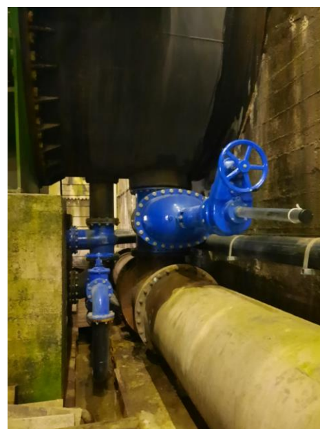
Slika 12: HE Zakučac – zasunska komora, jedna od četiri dovodne cijevi
