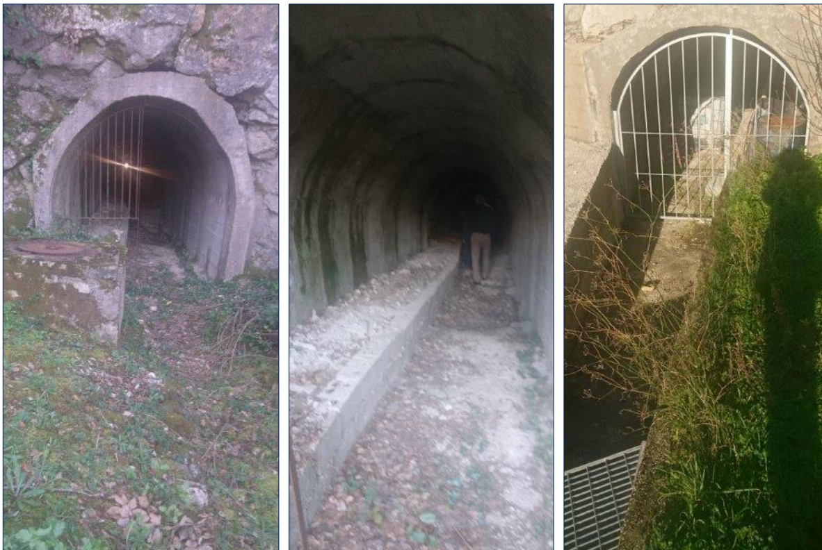
Slika 3-27 Hidrotehnički tunel Prapratno – Ulazni portal, kolektor u tunelu, izlazni portal
