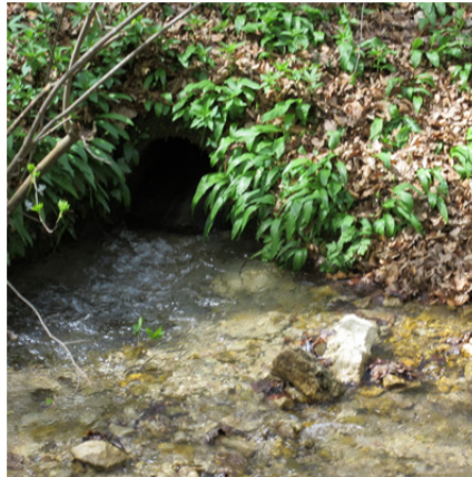
Slika 2.8. Preljev voda iz kaptaze nizvodno od vodozahvata Lobar
