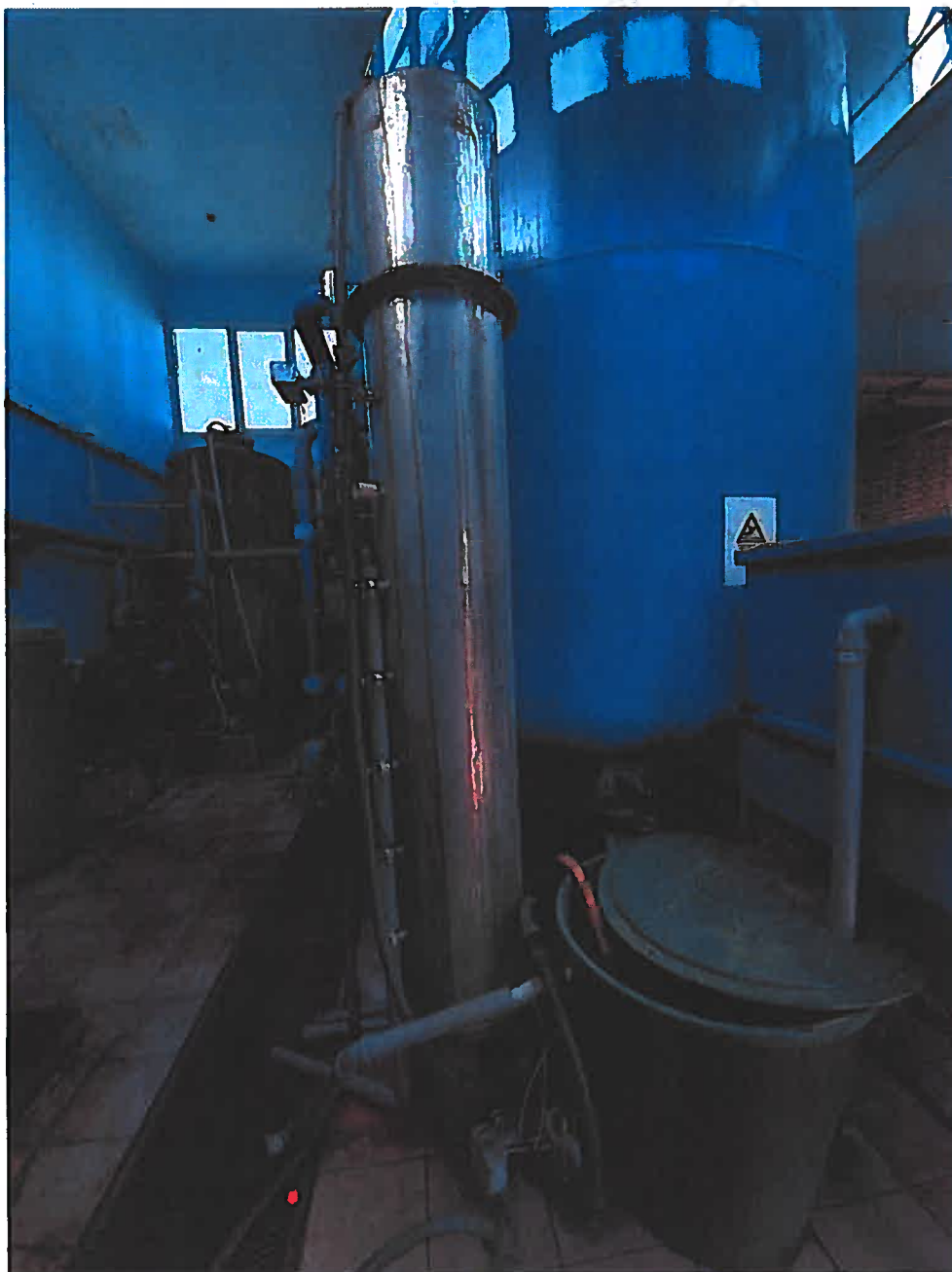
Slika 5.2.2. Fotografija pilot postrojenja s taložnikom i međuspremnikom (lijevo) za pokuse uklanjanja željeza, mangana i amonijak iz podzemnih voda Vodocrpilišta Jasenovac
