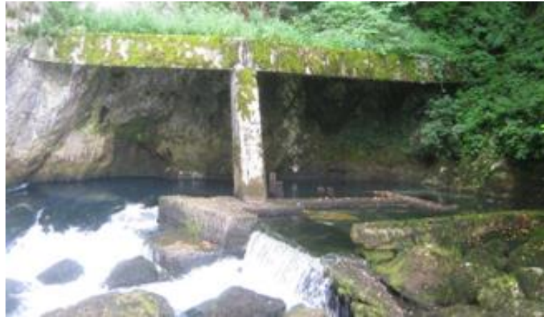
Slika 3.3: Vodozahvatni objekat na izvorištu Klokota
