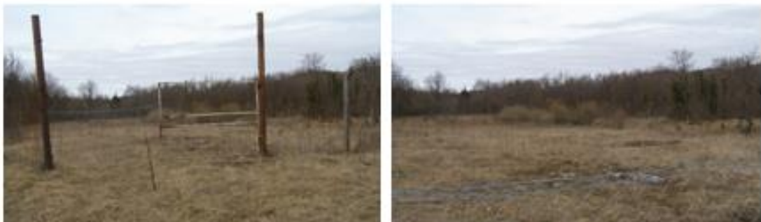
Slika 8.14: Sanirana deponija komunalnog otpada Prijeboj
