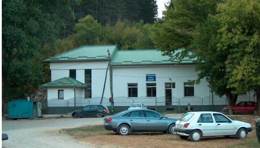
Slika 3.5: Pumpna stanica Klokot
