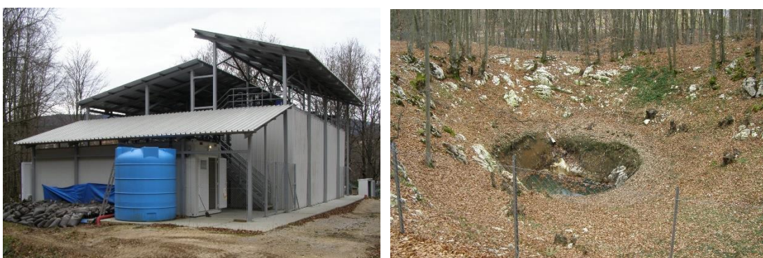
Slika.8.24: Privremeno PPOV (tip MBR) i ispusna jama "Rastovača"
