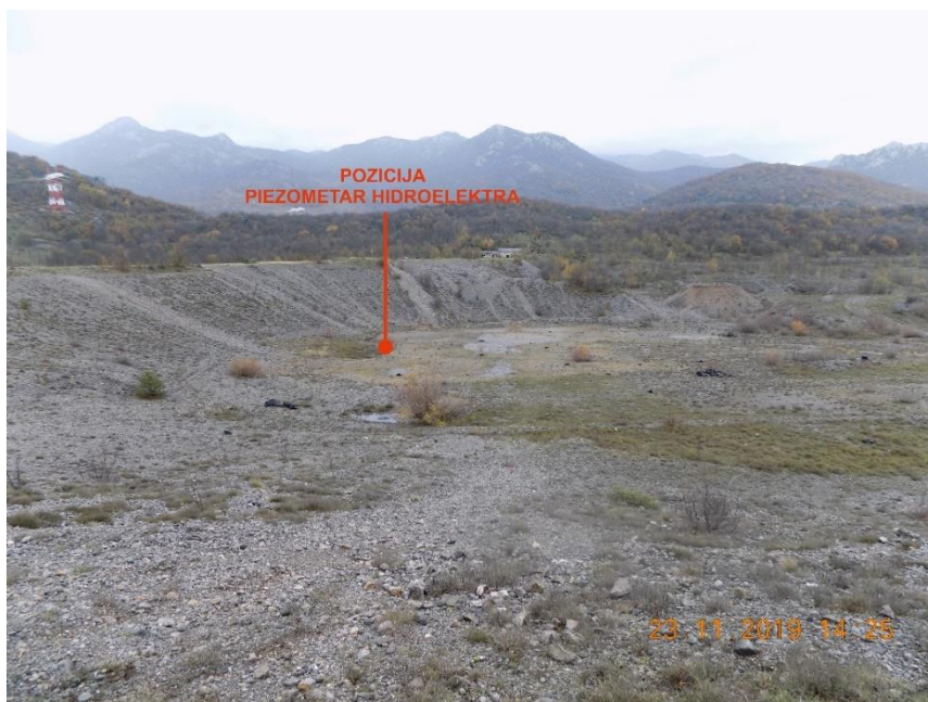
Slika 4.11 Pozicija plitkog piezometra Hidroelektra
