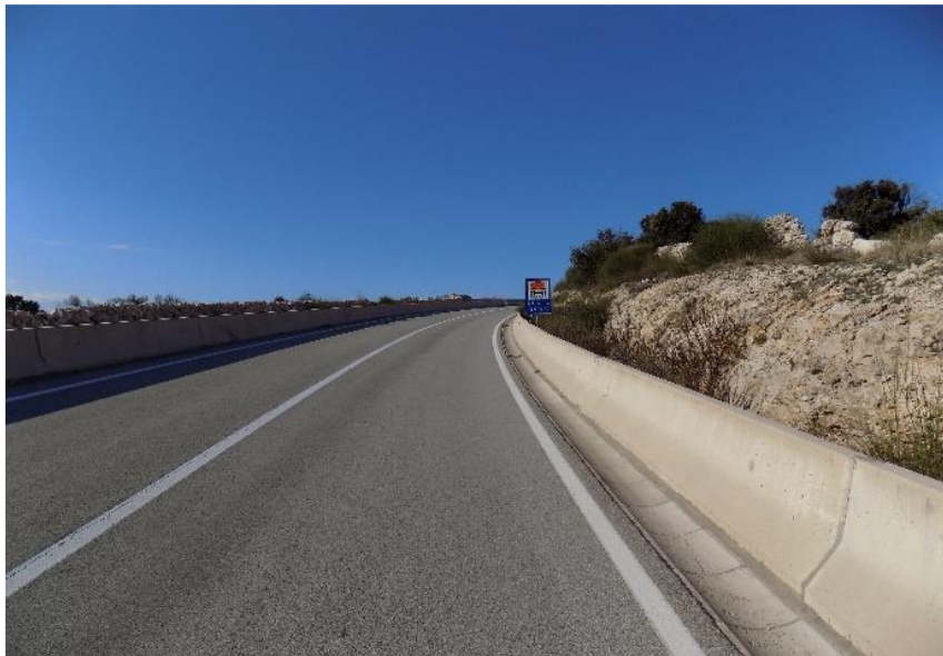
Slika 3.3. Magistralna otočka prometnica Cres – Lošinj sa zatvorenim sustavom odvodnje na dionici unutar zona sanitarne zaštite izvorišta pitke vode (GEO-5, 2015)
