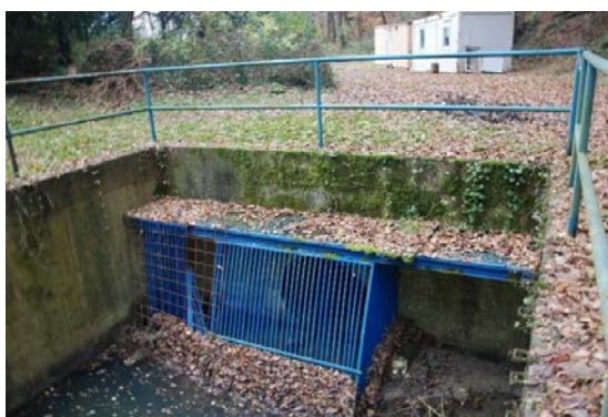
Slika 3.4: Kolektor na izlazu sa sliva potoka Kraljevec II, preuzeto iz „Studijske dokumentacije za pripremu projekata zaštite od poplava na slivu sjeverno Zagrebačko prisavlje“
