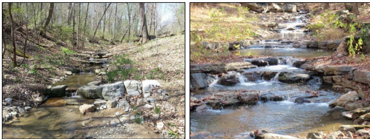
Slika 59. Hidrotehničke stepenice na planinskim bujičnim vodotocima u Škotskoj [6]
