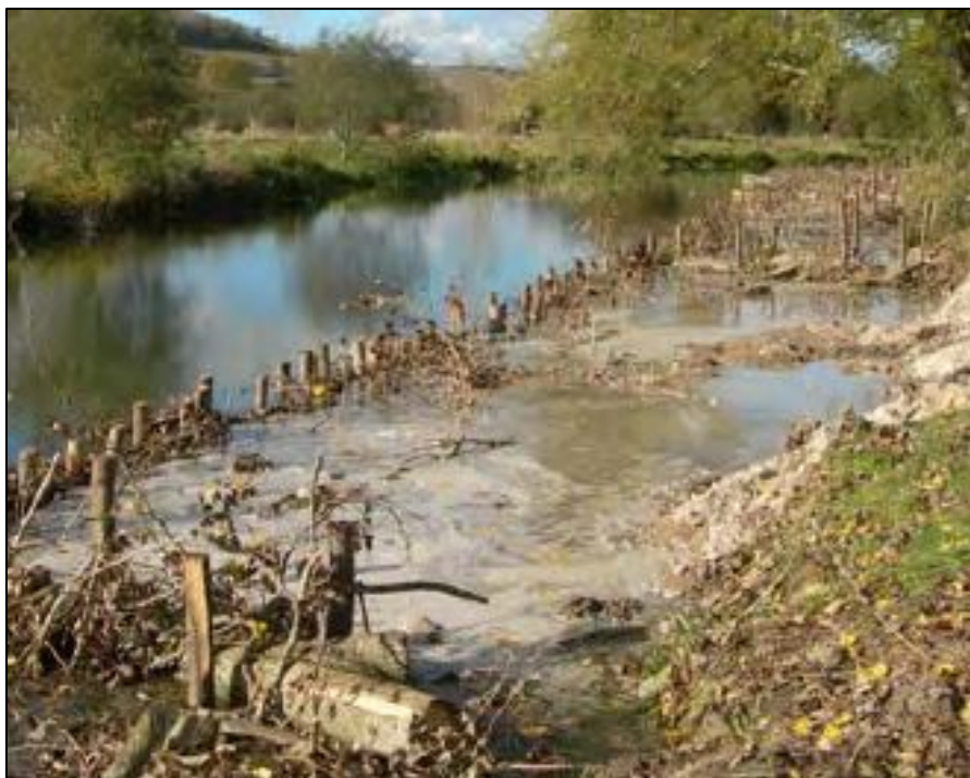
Slika 52. Početak taloženja sedimenta između postojeće obale i paralelne građevine [7]
