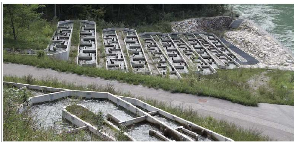
Slika 78. Riblja staza bazenskog tipa s vertikalnim prorezima na hidroelektrani Annabrücke na rijeci Dravi u Austriji [13]
