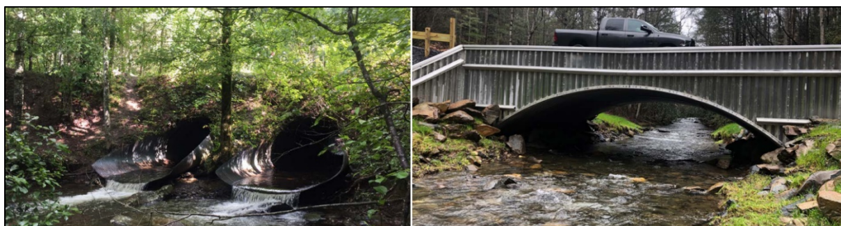
Slika 66. Prije (lijevo) i poslije (desno) rekonstrukcije propusta [14]
