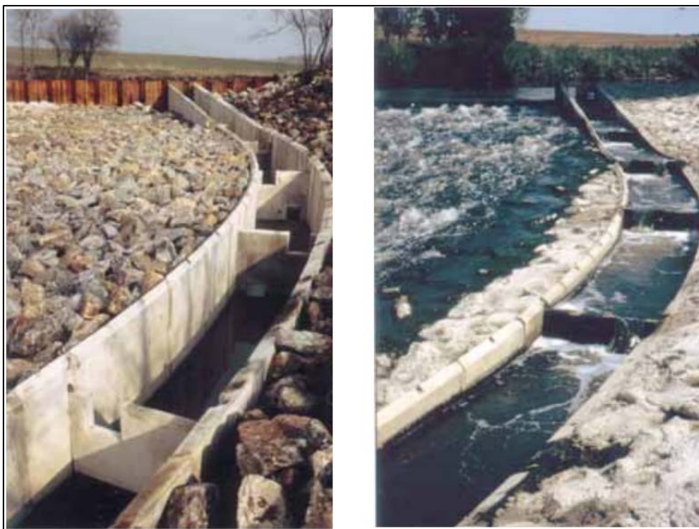
Slika 75. Riblja staza bazenskog tipa s otvorima i preljevima na rijeci Lippe u Njemačkoj [8]
