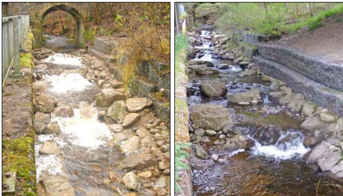
Slika 61. Revitalizirano korito rijeke Inchewan Burn u Škotskoj primjenom hidrotehničkih stepenica od krupnog kamenog materijala [16]
