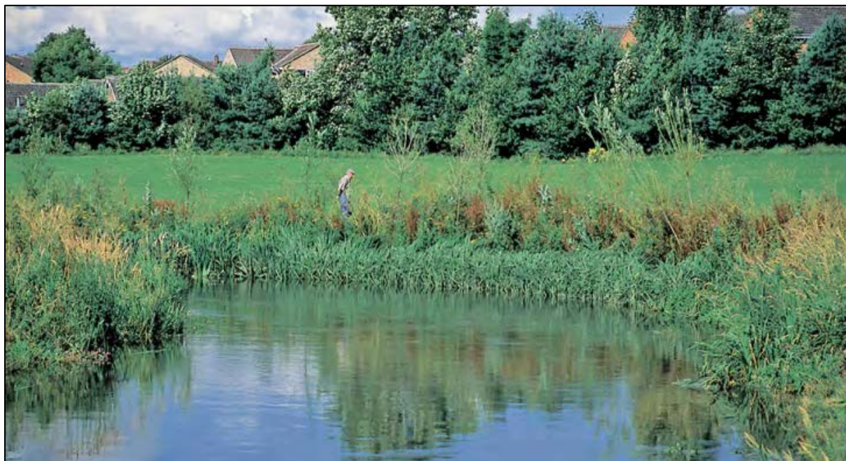
Slika 9. Obaloutvrda (tip 1) tri godine nakon izgradnje [8]
