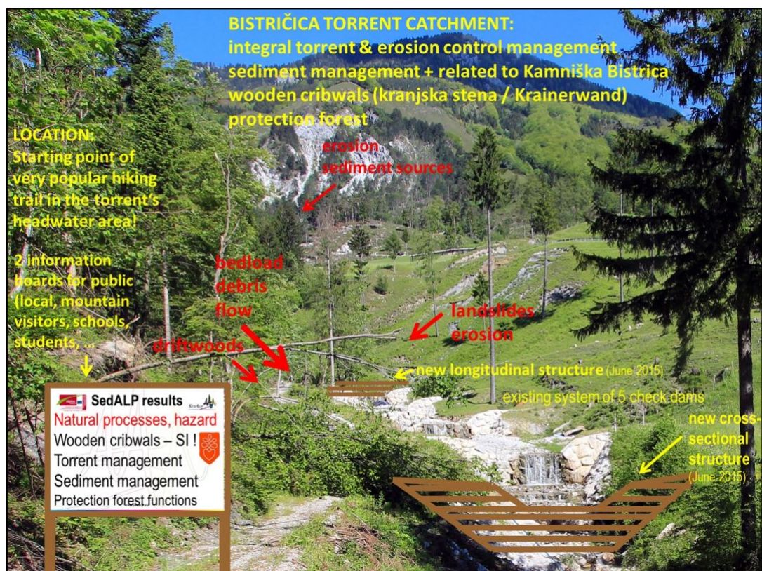
Slika 8. Fotografija s ucrtanim shematskim prikazom bujične pregrade i pokosa [13]
