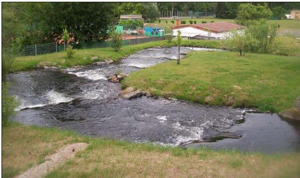
Slika 68. Prirodna riblja staza uz akumulaciju Obermaubach u Njemačkoj [2]
