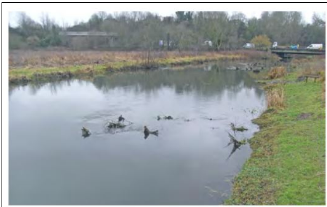
Slika 29. Fotografija lokacije pera neposredno nakon izgradnje pera [10]
