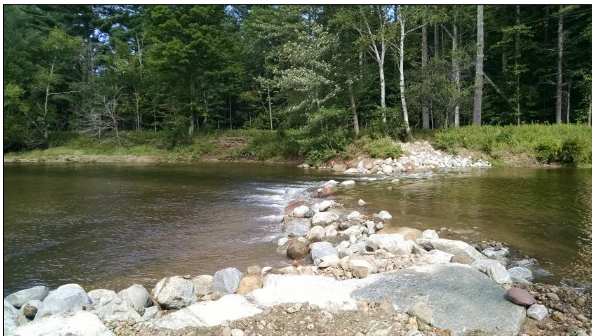
Slika 44. W-prag od krupnog kamenog materijala [13]
