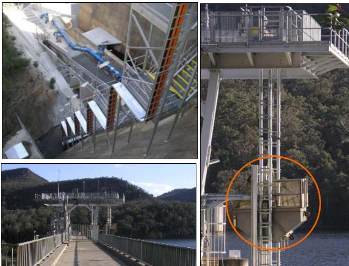
Slika 83. Riblji lift na Tallowa brani u Australiji [17]
