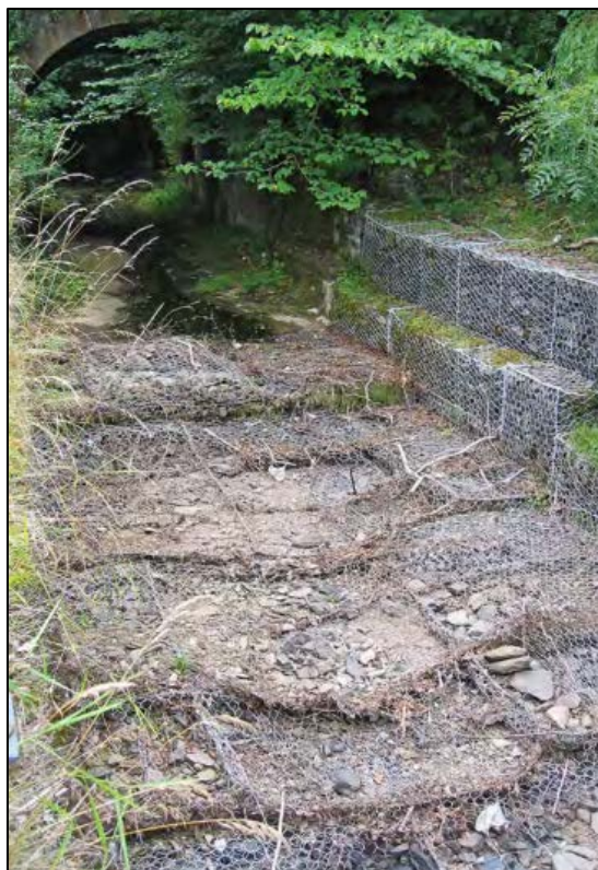
Slika 60. Degradirano korito rijeke Inchewan Burn u Škotskoj, kolovoz 2006. [16]
