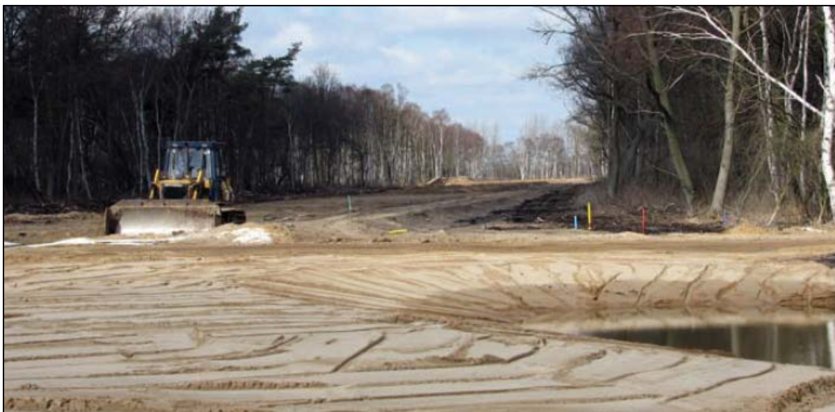
Slika 33. Čišćenje terena kao priprema za izgradnju nasipa [15]
