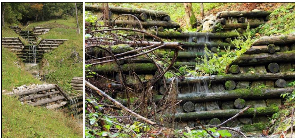
Slika 7. Drvene pregrade na bujici Čerinjščici (lijevo) i bujici Kolovcu (desno) [2]
