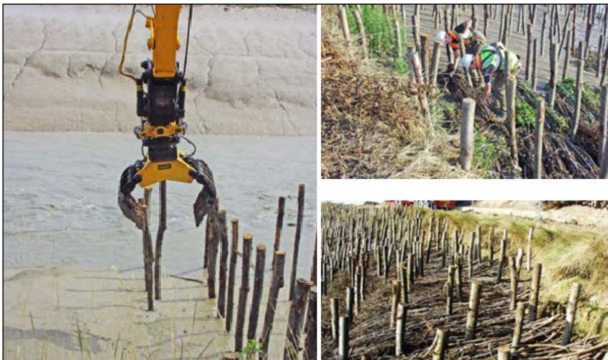
Slika 12. Radovi tijekom izgradnje obaloutvrde (tip 2) [9]
