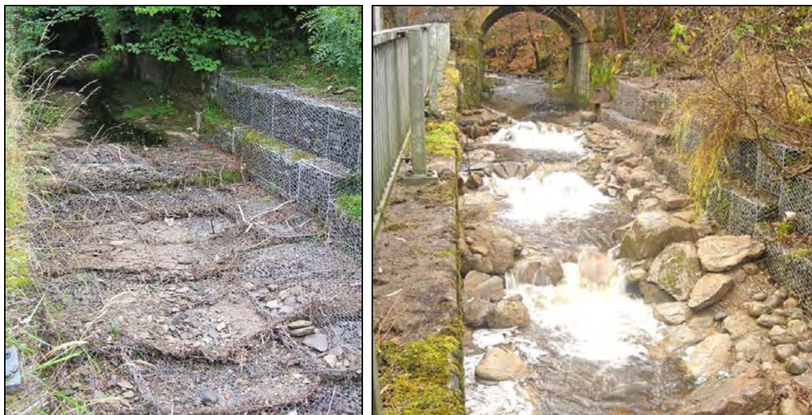
Slika 6. Stanje korita potoka Inchewan Burna prije radova u kolovozu 2006. (lijevo) i nakon radova u prosincu 2007. (desno) [24]
