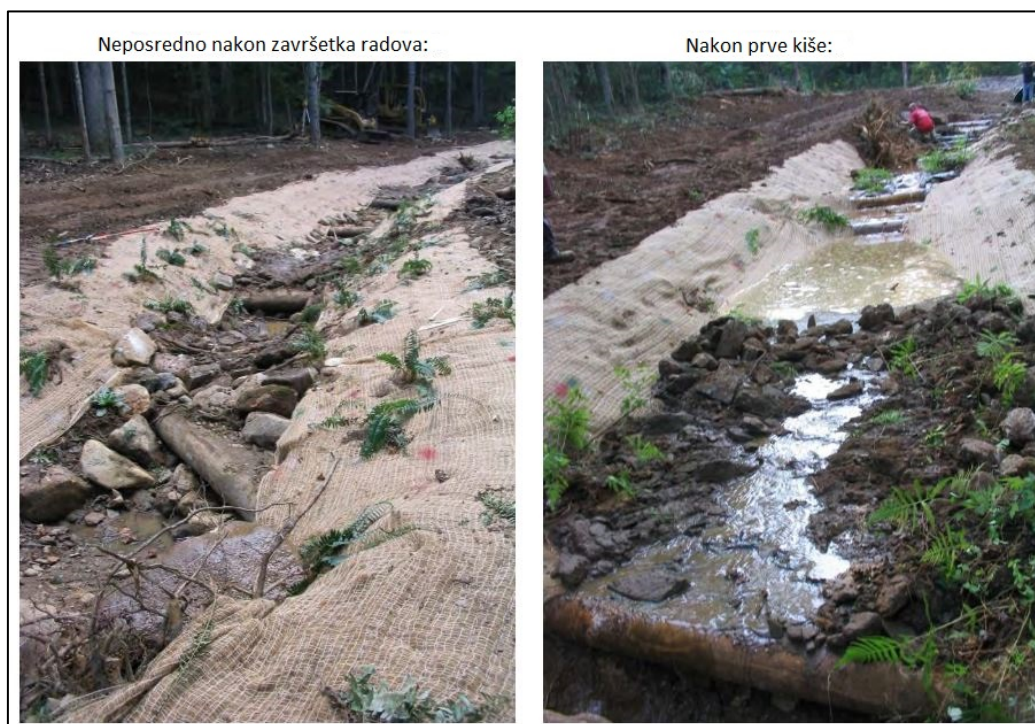
Slika 46. Fotografija vodotoka nakon završetka radova i nakon prve kiše [14]
