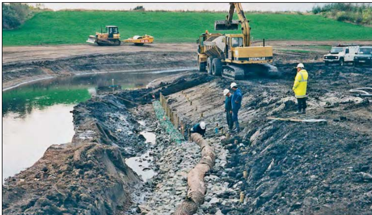
Slika 7. Obaloutvrda (tip 1) tijekom izgradnje [8]
