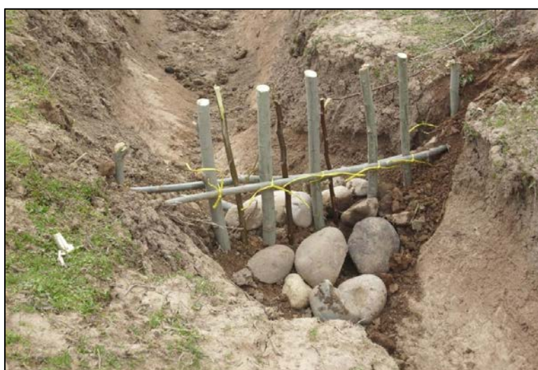
Slika 10. Primjena živih palisada u jaruzi u zapadnom Tadžikistanu [14]
