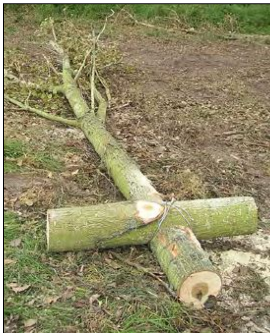
Slika 27. Izveden križni spoj za sidrenje u obalu [10]
