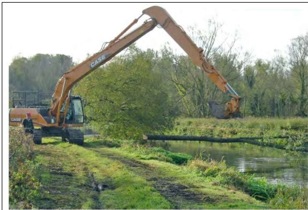
Slika 28. Izvođenje radova – transport i postavljanje stabala [10]
