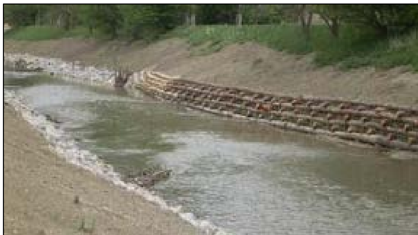
Slika 17. Obaloutvrda od drvenih sanduka odmah nakon izgradnje [12]
