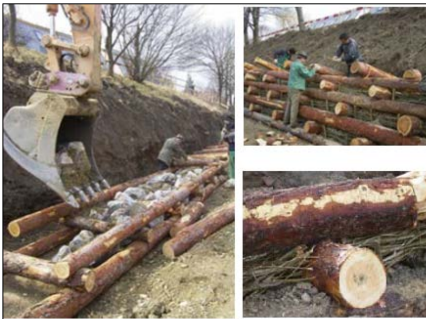
Slika 16. Izgradnja obaloutvrde (tip 3) [12]
