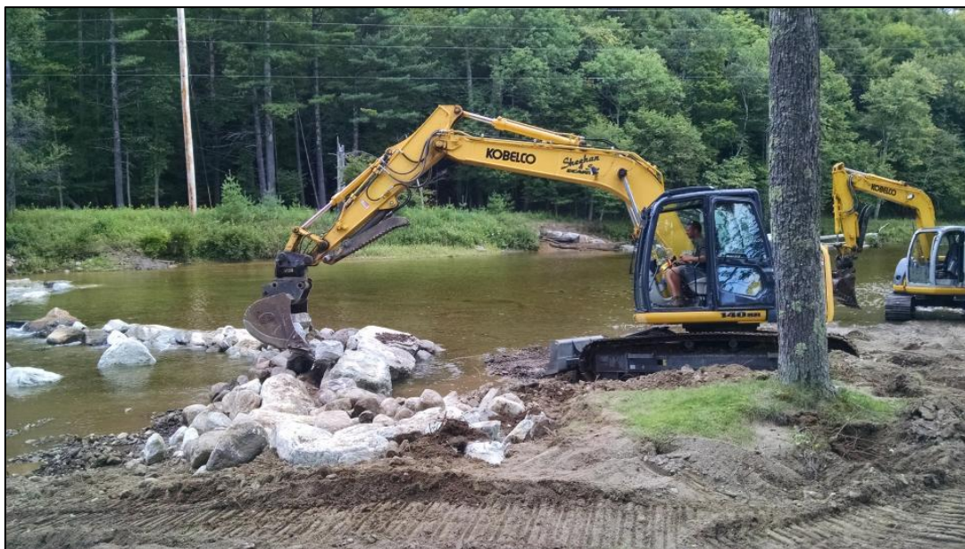
Slika 43. Izgradnja novog kamenog praga – izgradnja korijena praga u obali [13]
