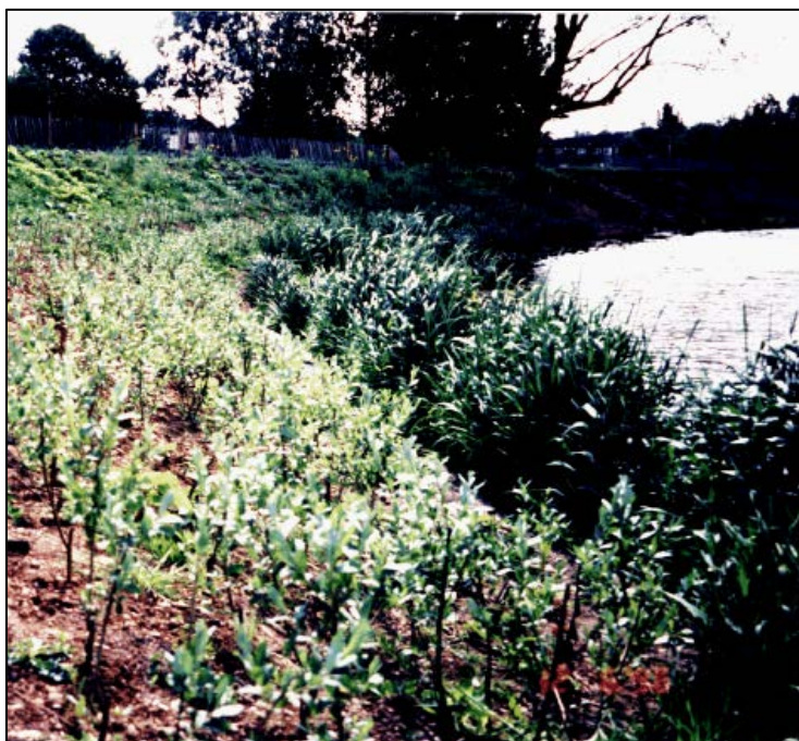
Slika 8. Obaloutvrda (tip 1) četiri mjeseca nakon sadnje vrba ( Salix sp. ) [7]
