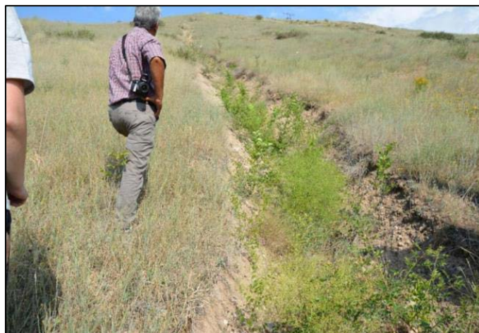
Slika 13. Razvoj vegetacije na drenažnim fašinama i živoj palisadi u vododerini u sjevernom Tadžikistanu [1]
