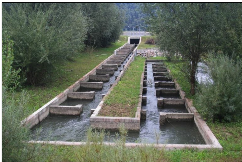
Slika 67. Tehnička riblja staza uz HE Blanca u Sloveniji na rijeci Savi, autorica: E. Ocvirk [2]
