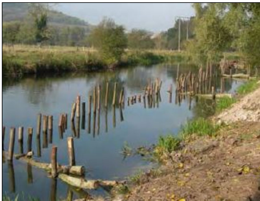
Slika 51. Izgradnja paralelne građevine (kolaca) i traverzi (trupaca) u koritu rijeke Avon [7]
