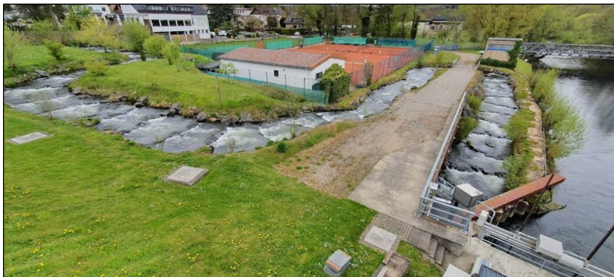
Slika 73. Prikaz trenutnog stanja riblje staze na akumulaciji Obermaubach [12]
