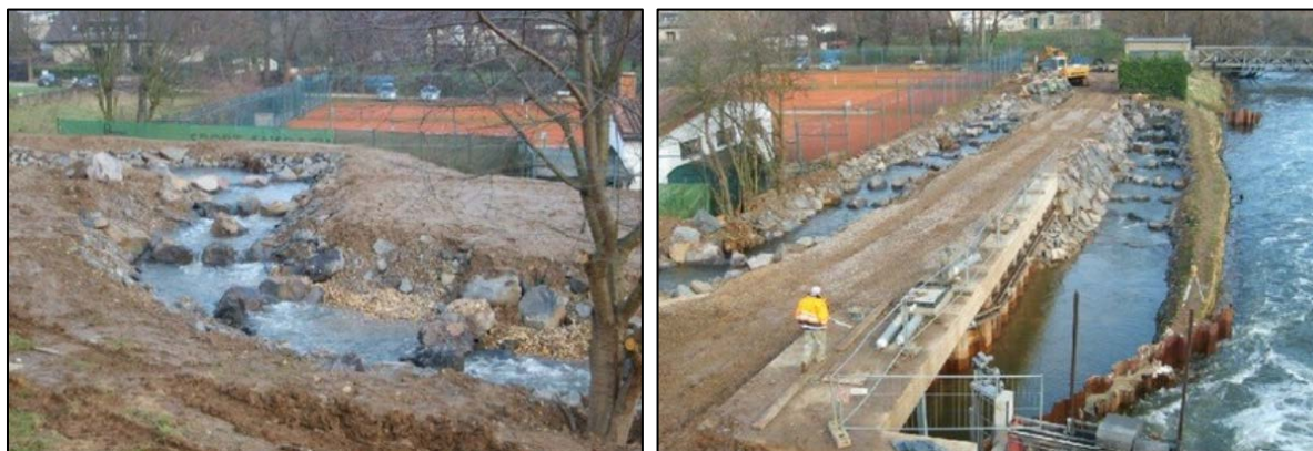
Slika 72. Riblja staza na akumulaciji Obermaubach za vrijeme izgradnje [11]
