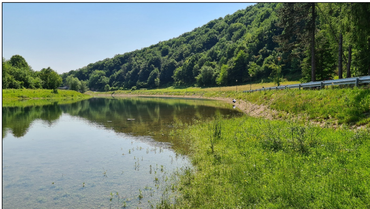
Slika 2. Obaloutvrda na Gornjoj Dobri uzvodno od brane Bukovnik, izgrađena od kamena u betonu
