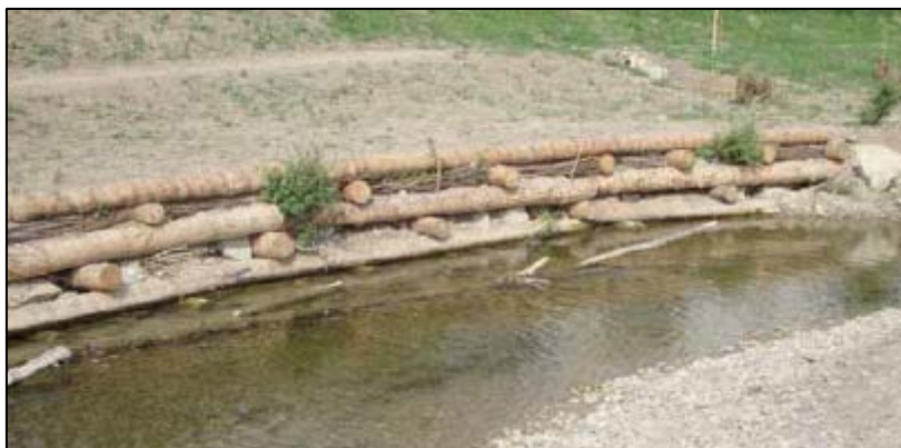
Slika 18. Obaloutvrda od drvenih sanduka odmah nakon izgradnje [13]
