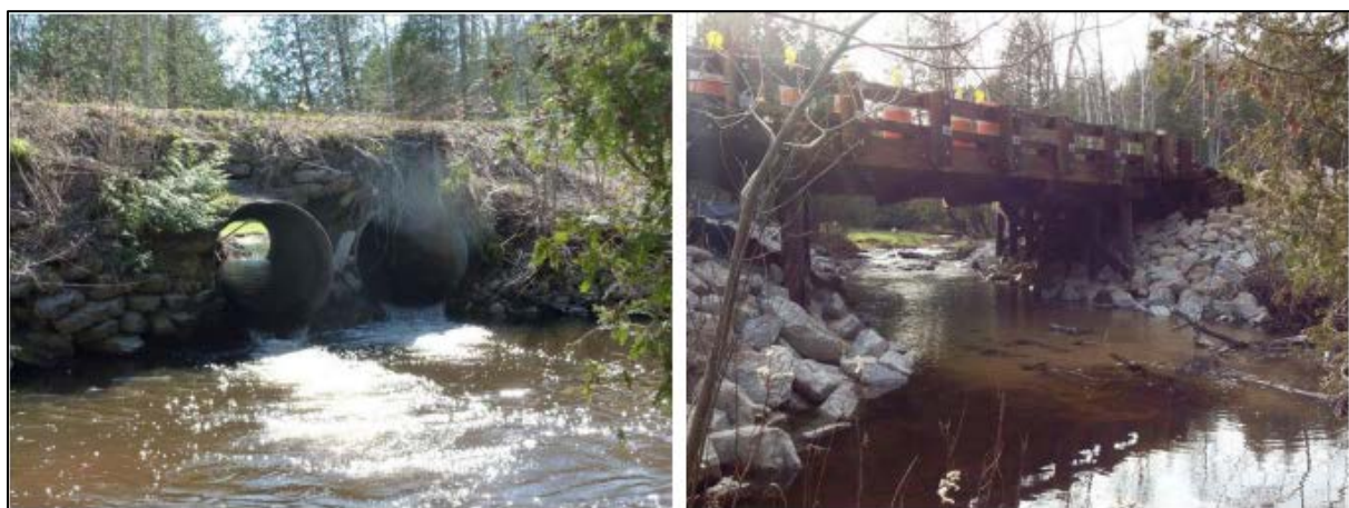
Slika 63. Cijevni (lijevo) i pločasti (desno) propust [2]
