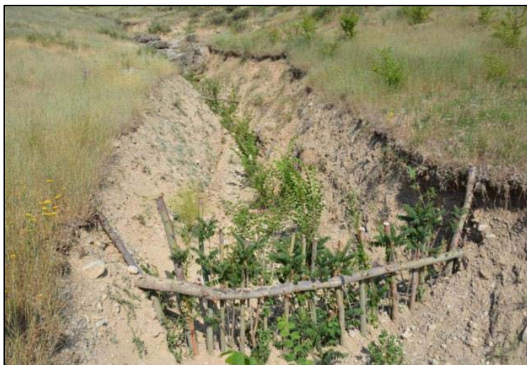
Slika 12. Primjena drenažnih fašina i živih palisada na vododerini u sjevernom Tadžikistanu [1]
