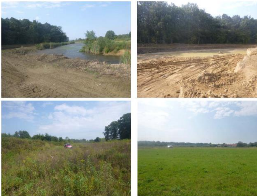
Slika VIII-5 Nalazište materijala, lokacija prokopa Korana-Kupa
