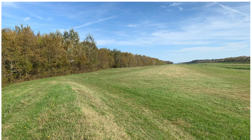
Slika 9. Prikaz lijevog nasipa kanala Kupa-Kupa na području bočnoga preljeva u 6. km
