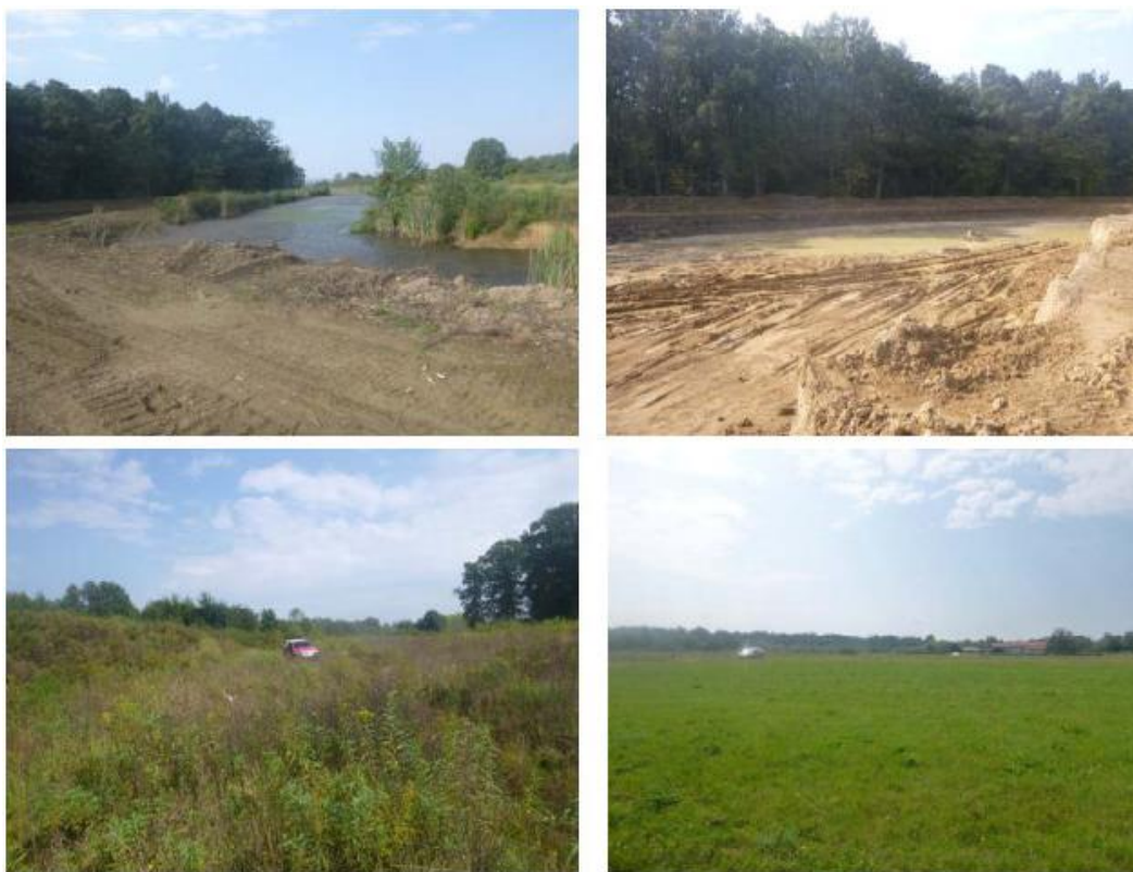
Slika VI-5 Nalazište materijala, lokacija prokopa Korana-Kupa
