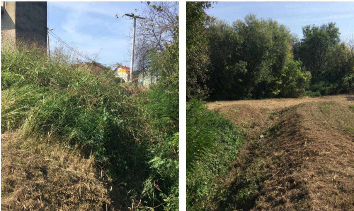
Slika 19: Postojeći čep br.1 i pripadajući kanal
