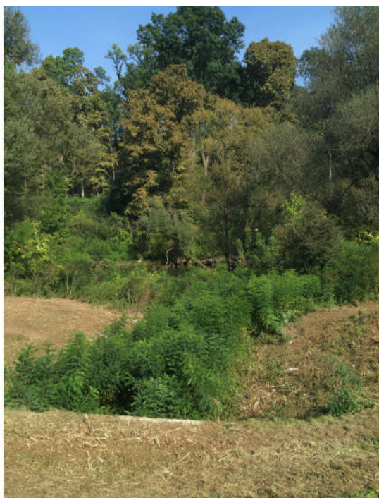
Slika 23: Lokacija postojećeg propusta u Odru - čep br. 3
