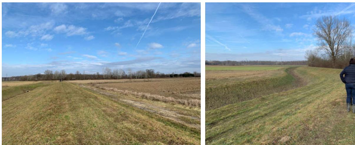
Slika 22: Trasa postojećeg kanala
