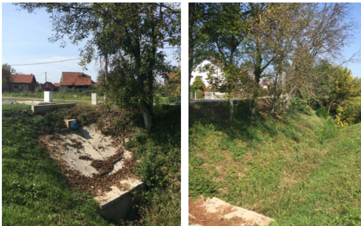
Slika 20: Postojeći čep br.2 i pripadajući kanal
