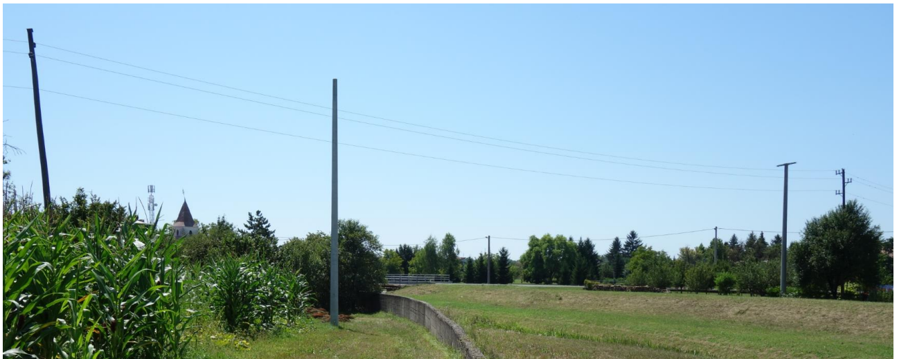
Slika 2-14: Prelaz mreže iznad Lekeničkog potoka
