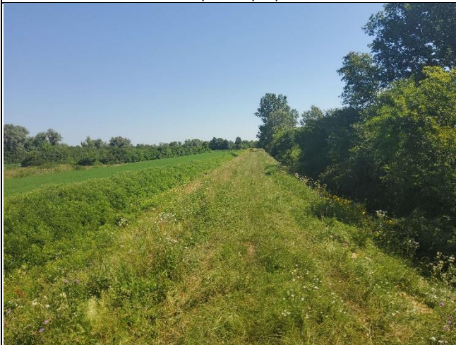
Slika 3.10 Kanal s lijeve strane nasipa
