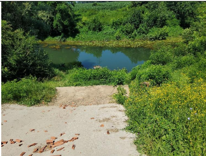
Slika 3.8 Betonirani dio nasipa kod propusta
