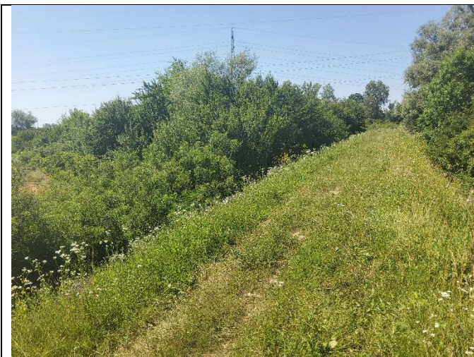
Slika 3.2 Oštećena kruna nasipa, vidljiva površinska erozija i slijeganje rubnih dijelova kruna nasipa za cca 30 cm
