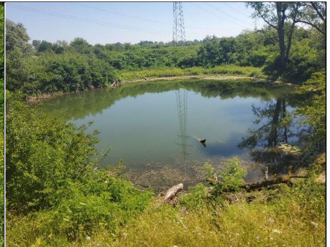
Slika 3.9 Jezero s desne strane nasipa promjera cca 50 m
