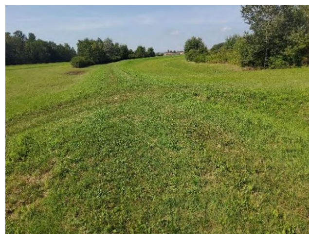
Slika 3.9 Slijeganje nasipa u zoni „rampi“ – lijevi nasip, stacionaža cca km 2+160
