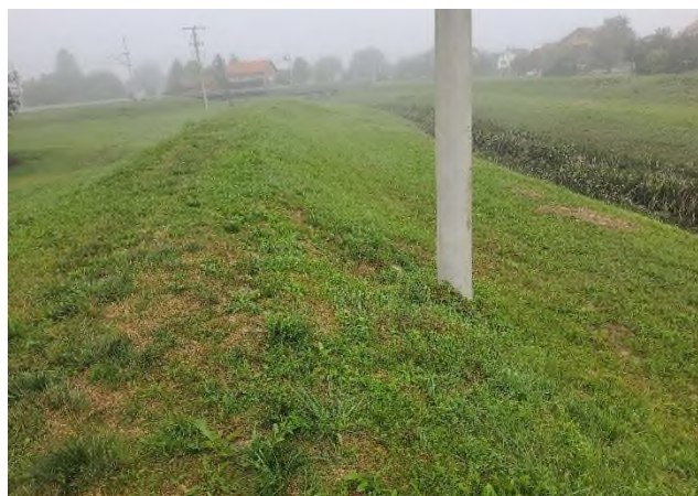
Slika 3.7 Dalekovodni stup u nožici nasipa – desni nasip, stacionaža cca km 1+540
