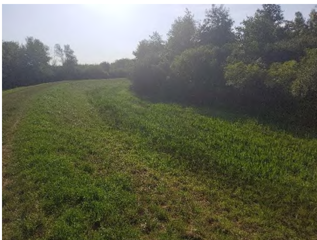
Slika 3.14 Močvarni teren u nožici nasipa – desni nasip, stacionaža cca od km 2+300 do 2+480
