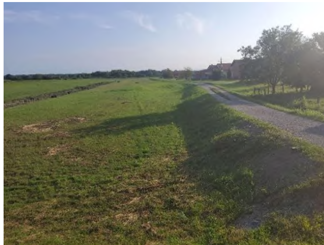
Slika 3.5 Lokalni put po kruni nasipa – desni nasip, stacionaža cca km 0+950 do 1+100
