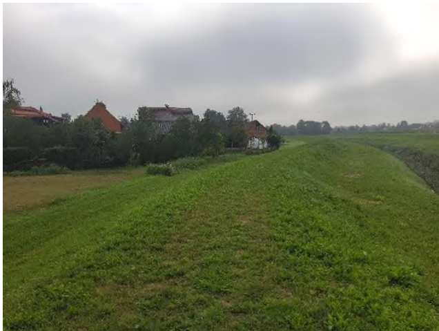
Slika 3.10 Objekti u zoni nožice nasipa – lijevi nasip, stacionaža cca km 0+530 do 0+570
