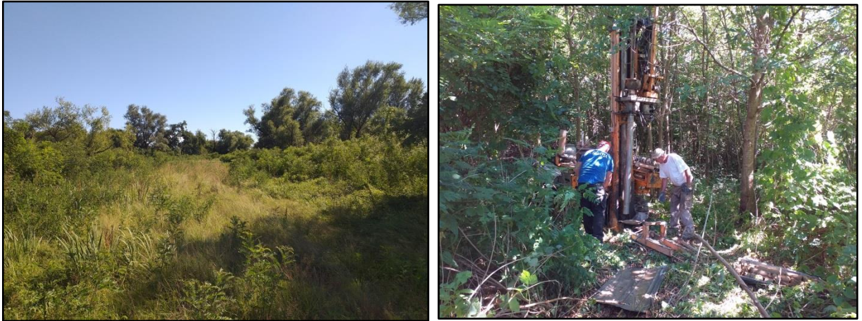
Slika 5. Lokacija potencijalnog nalazišta materijala - bušotina N1
