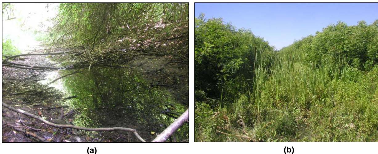
Slika 15. Kanali na istražnom prostoru: (a) ispunjeni vodom i (b) suhi i obrasli vegetacijom
