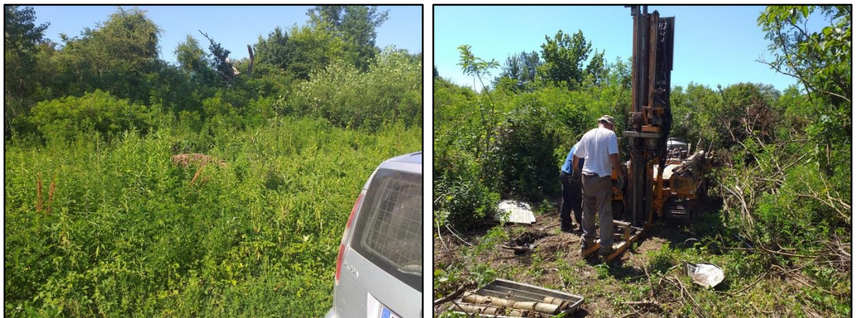
Slika 6. Lokacija potencijalnog nalazišta materijala - bušotina N2
