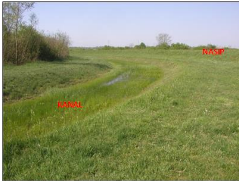
Slika 15. Kanal uz postojeći nasip; dijelom ispunjen vodom
