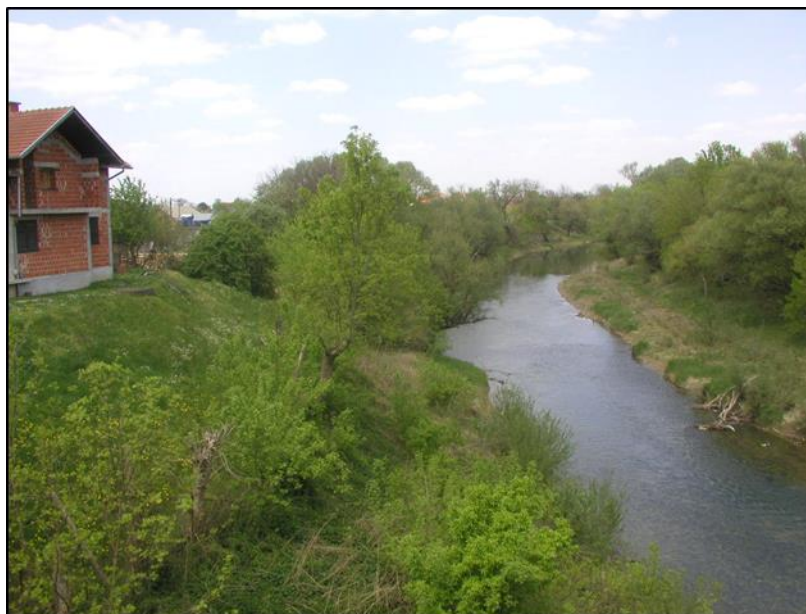
Slika 16. Teren na početku trase budućeg nasipa – drveće i grmlje uz obalu rijeke
