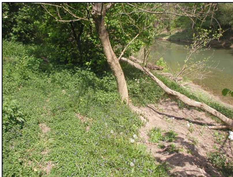
Slika 18. Manji odron na obali rijeke – vlačna pukotina i nagnuto drvo
