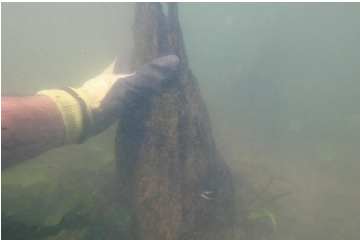
Sl. 22 Ostatci drvenog pilota na položaju O.1 u koritu rijeke Odre (etapa 4)
