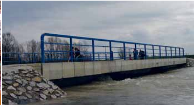
Mostovi utječu na smanjenje protočne sposobnosti otvorenog vodotoka (foto: D. Čevizović)
