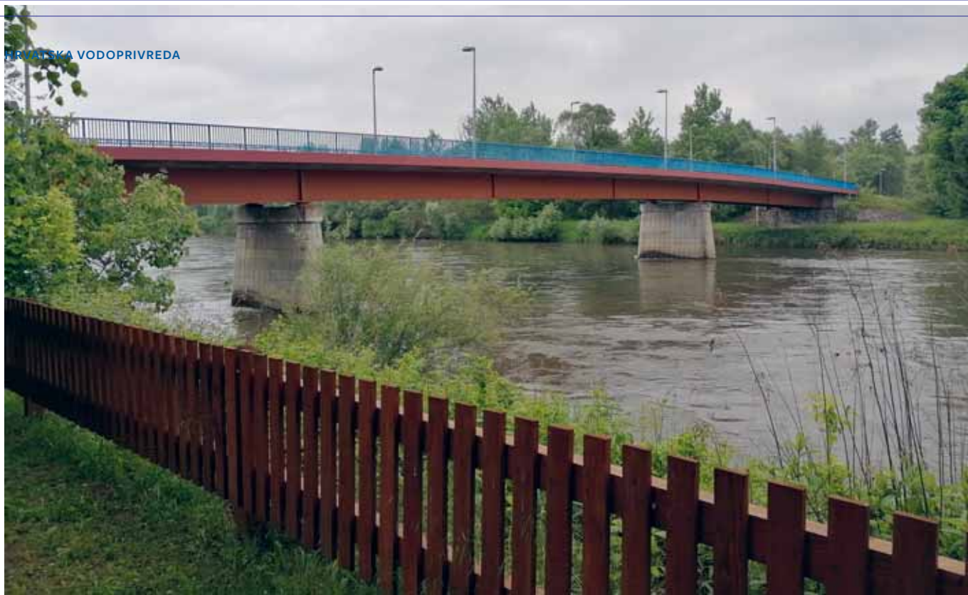
Most u Sv. Martinu na Muri-jedna od sedam lokacija za postavljanje vodomjera
