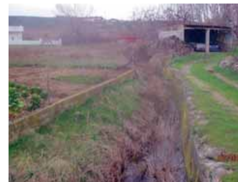
Korito bujičnog vodotoka Koštanica prije radova, zemljano i neregulirano
