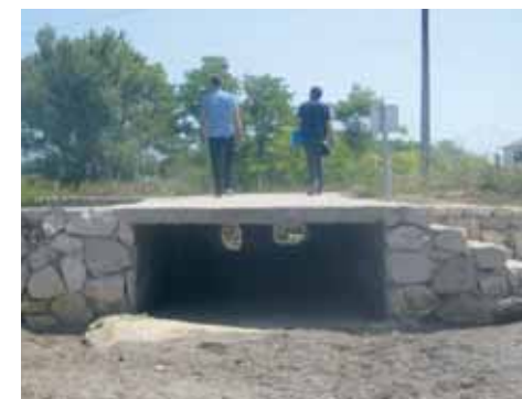
Postojeći propust na mjestu gdje se trasa bujice križa s nerazvrstanom cestom
