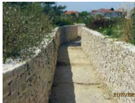
Izvedeni radovi uređenja na vodotoku Koštanica, pogled iz reguliranog korita
