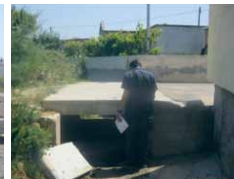
Postojeći propust na mjestu gdje se trasa bujice križa s poljskim putem
