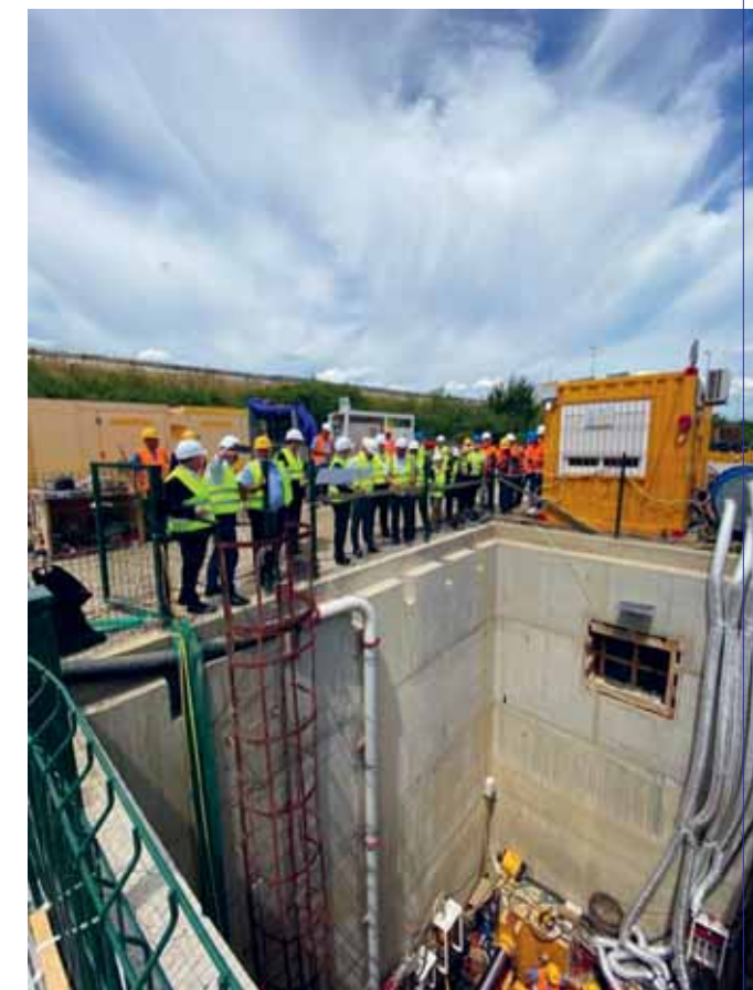
Radovi mikrotuneliranja, bušenja tunela ispod rijeke Save
