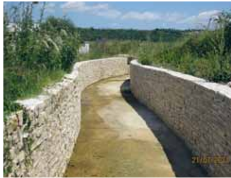
Regulacija vodotoka izgradnjom otvorenog pravokutnog kanala
