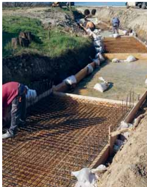
Početak radova uređenja na najnižvodnijoj dionici segmentalnom izvedbom armirano-betonske podne ploče
