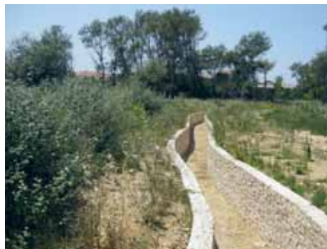
Izvedeni radovi uređenja nizvodno od stacionaže o+353,44 km
