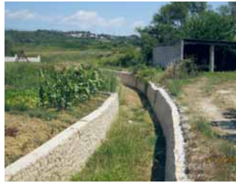
Izvedeni radovi uređenja na vodotoku uzvodno od stacionaže o+098,37 km
