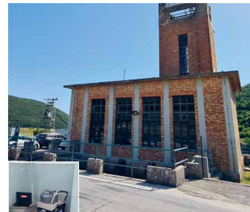
Automatska mjerna postaja na Raši (smještena unutar crpne stanice Štalije)
