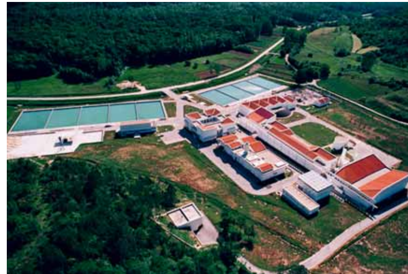
Uređaj za kondicioniranje pitke vode Butoniga Q=1.000 l/s (Istarska županija)
