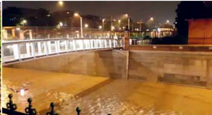
Poplavljeni podvožnjak u Miramarskoj, Zagreb
