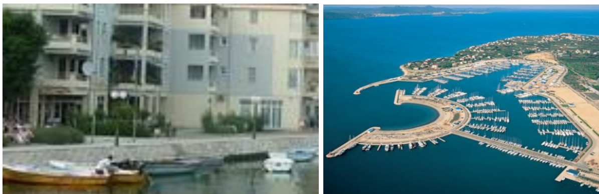
Sl. 4.16. Primjeri izgradnje obale u Omišu i lukobrana u Marini Sukošan
