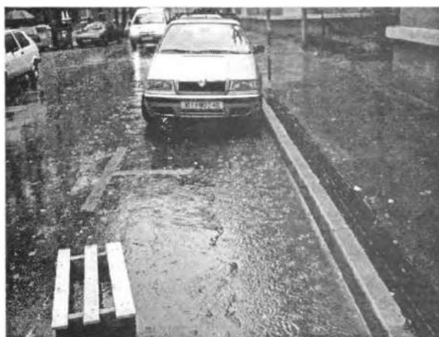
Slika 4: Posljedica manjkave odvodnje – zadržavanje vode uz rub kolnika
