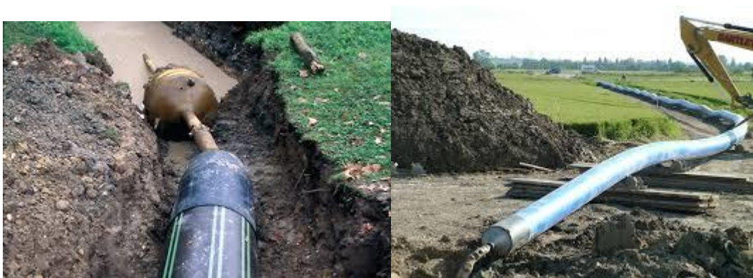
Slika 6. Prikaz izlazne građevinske jame s spojenim cjevovodom
