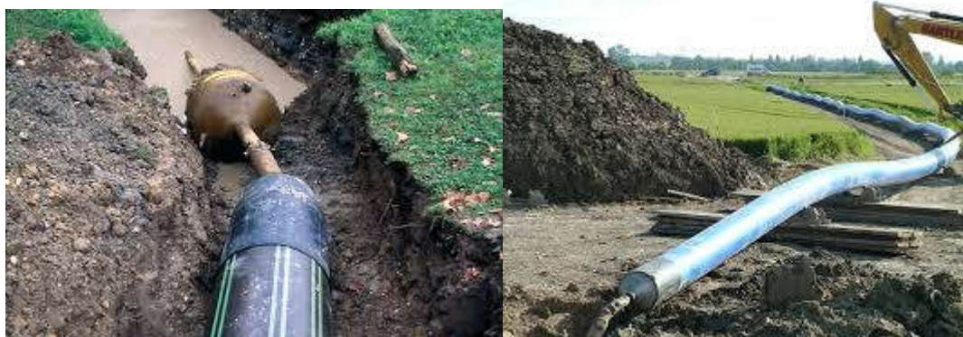
Slika 7. Prikaz izlazne građevinske jame sa spojenim cjevovodom
