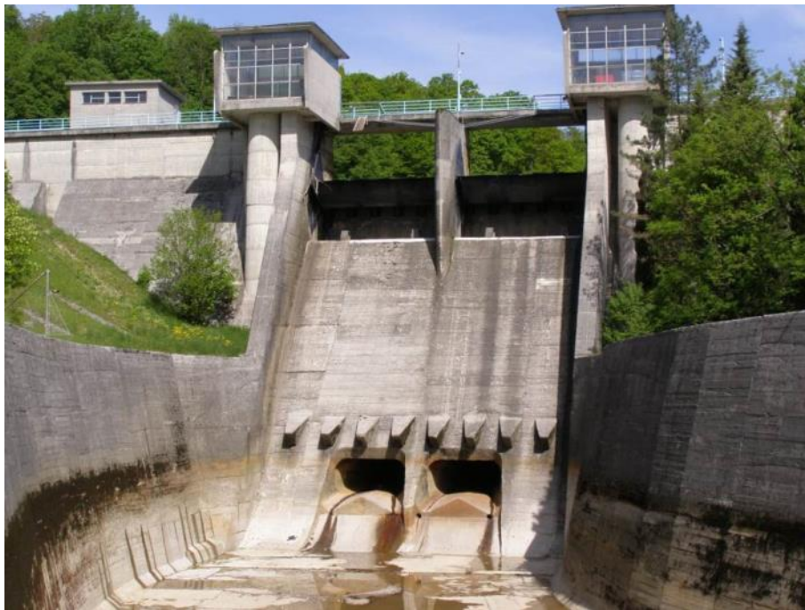
Slika 2.1-34 Nizvodna strana brane -preljev i temeljni ispust.
