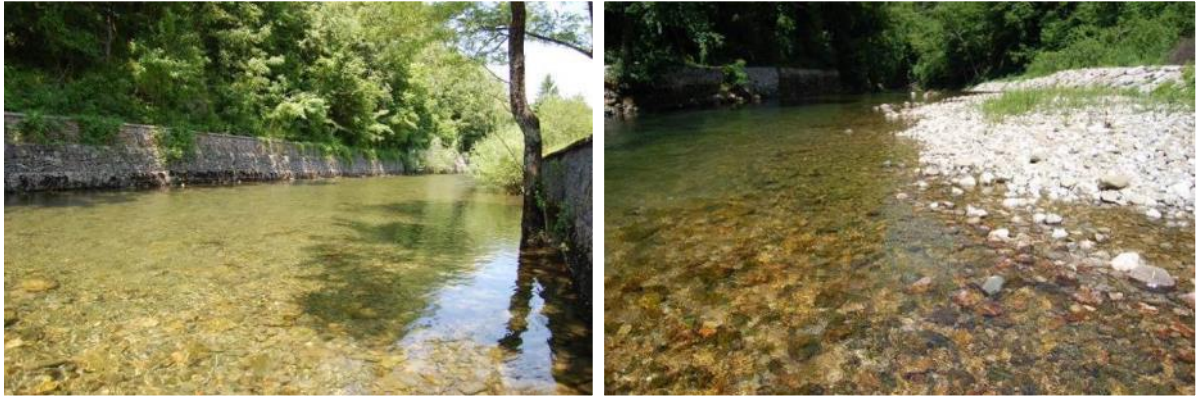
Slika 2.3-6 Utvrđeni dio toka Rječine uzvodno (lijevo) i nizvodno (desno) od utoka potoka Sušica (foto: V. Šegota).
