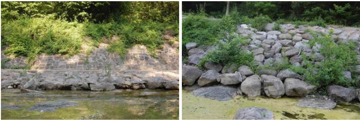
Slika 2.3-10 Obale Rječine na lokaciji R4 s utvrđenim obalama (foto: V. Šegota).
