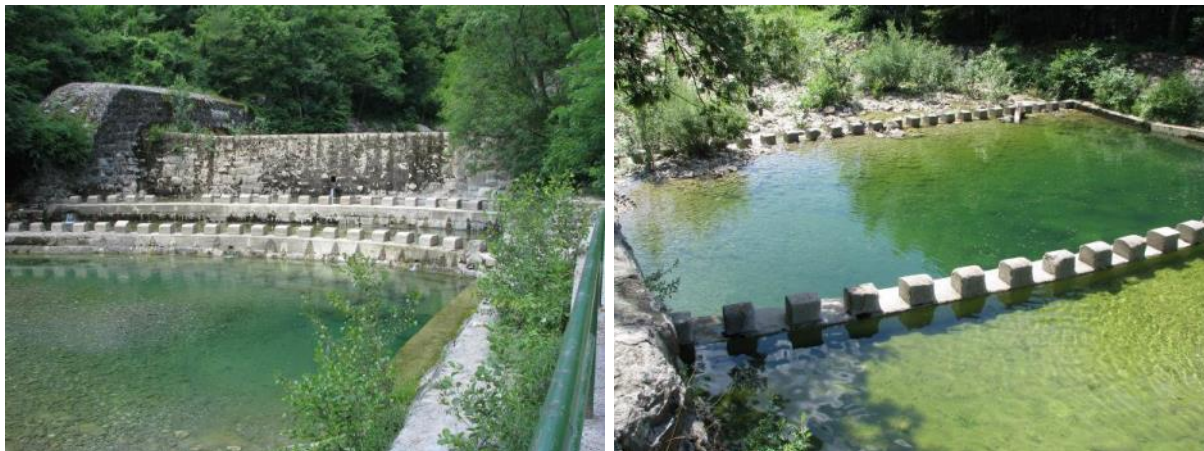
Slika 2.3-26 Vodne stepenice na dijelu nizvodno od brane Valići (terenski obilazak, travanj 2015.).
