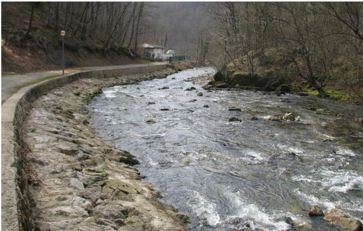
Slika 2.3-22 Obaloutvrde nizvodno od izvorišta Rječine (terenski obilazak, ožujak 2015.).
