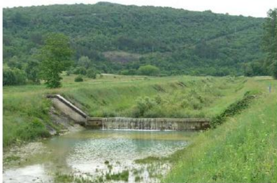
Slika 2.1.1.12. Vodne stube (10) između profila br. 9 i 10
