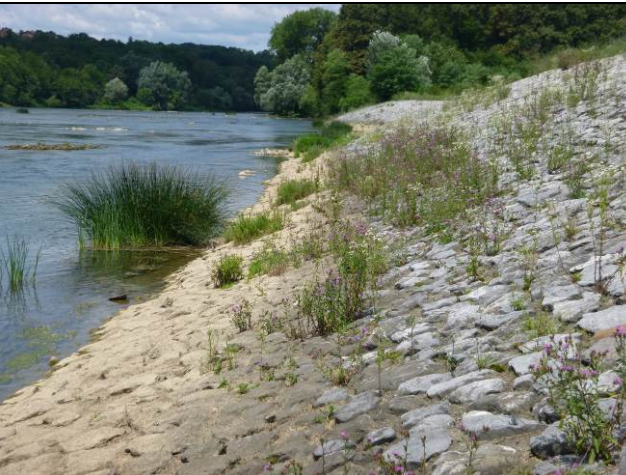
T 31: Betonsko-blokovita obloga pokosa lijeve obale rijeke Kupe
