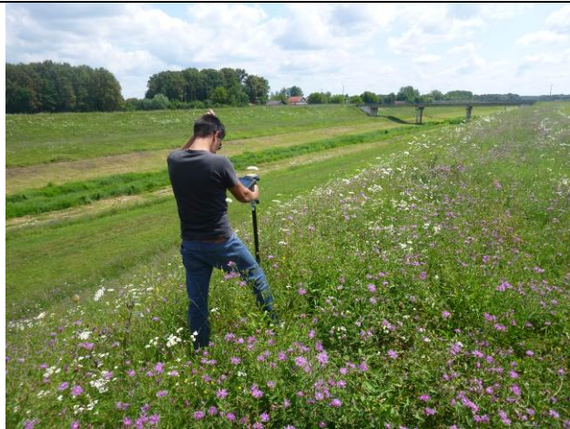
T 4: Postojeći desni nasip kanala 'Kupa-Kupa'.
