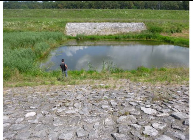
T 12: Betonsko-blokovite obloge pokosa kanala sa koritom kanala ispunjenim vodom. Korito kanala zaraslo močvarnim biljem.
