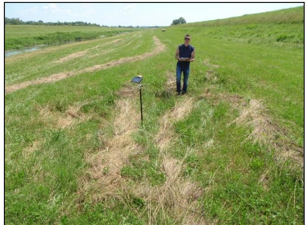
T 9: Sufozija na priobalnoj strani površine oko 20 m<sup>2</sup> s amplitudom slijevanja do 0,5 m.
