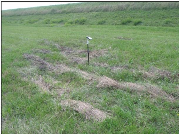
T 10: Sufozija na priobalnoj strani površine oko 14 m<sup>2</sup> s amplitudom slijevanja do 0,5 m.
