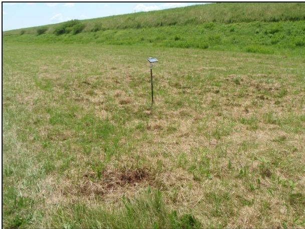
T 14: Sufozija na priobalnoj strani površine oko 30 m<sup>2</sup> s amplitudom slijeganja do 0,4 m.
