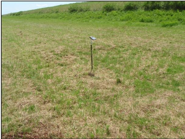
T 12: Sufozija na priobalnoj strani površine oko 12 m<sup>2</sup> s amplitudom slijeganja do 0,3 m.
