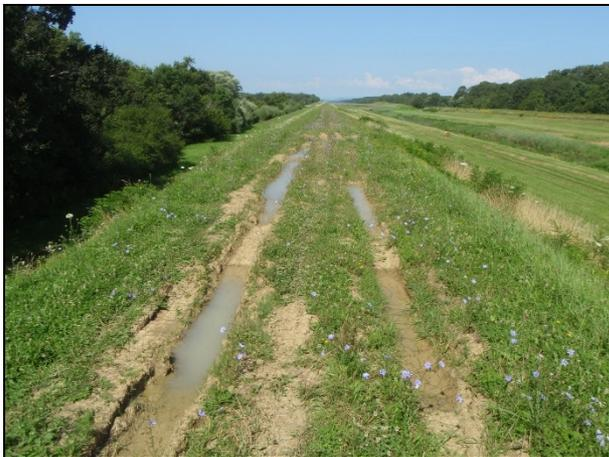
T 6: Kolotrazi ukupne širine oko 2,5 m i duljine oko 293 m na kruni nasute građevine s amplitudom slijevanja do 0,30 m. U kolotrazima mjestimično registrirana zaostala voda.
