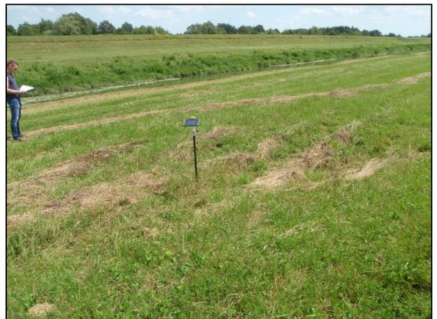
T 11: Sufozija na priobalnoj strani površine oko 22 m<sup>2</sup> s amplitudom slijevanja do 0,7 m.
