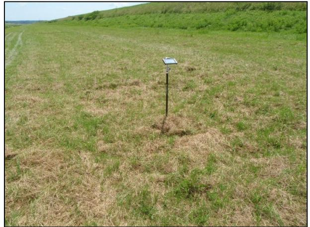
T 13: Sufozija na priobalnoj strani površine oko 6 m<sup>2</sup> s amplitudom slijeganja do 0,3 m.
