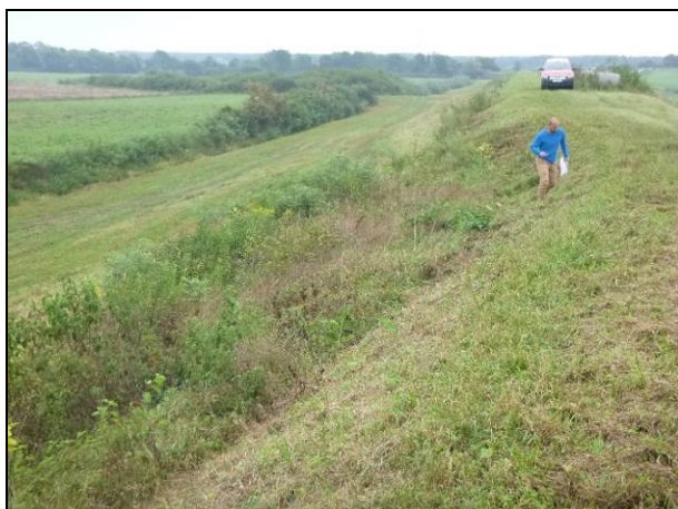
T 6: Ožiljak klizišta na zaobalnom pokosu nasipa, klizanjem je zahvaćen cijeli pokos i dio krune nasipa, skok u čelu klizišta je oko 2 m.
