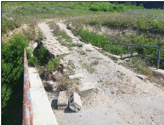
T 12: Odron u pokosu kanala uslijed čega je došlo do urušavanja temelja mosta. Odron je duljine 20 m i širine 30 m, sa skokom u čelu oko 3 m. Urušena je cijela jedna strana mosta što ugrožava siguran prijelaz preko mosta.
