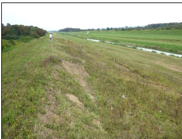
T 13: Niz od nekoliko uzastopnih klizišta na priobalnom pokosu nasipa. Cijela zona klizanja dugačka je preko 120 m.
