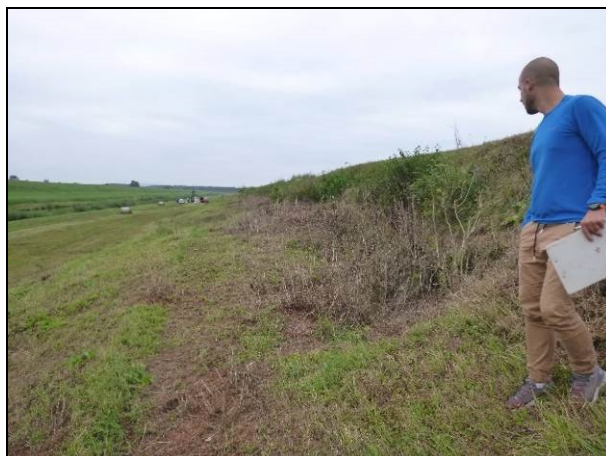
T 6: Ožiljak klizišta na priobalnom pokosu nasipa. Klizanjem je zahvaćena cijela visina pokosa, a skok u čelu klizišta je oko 2 m.
