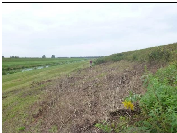
T 7: Klizište na priobalnoj strani tijela nasipa sa skokom u čelu od oko 2 m.
