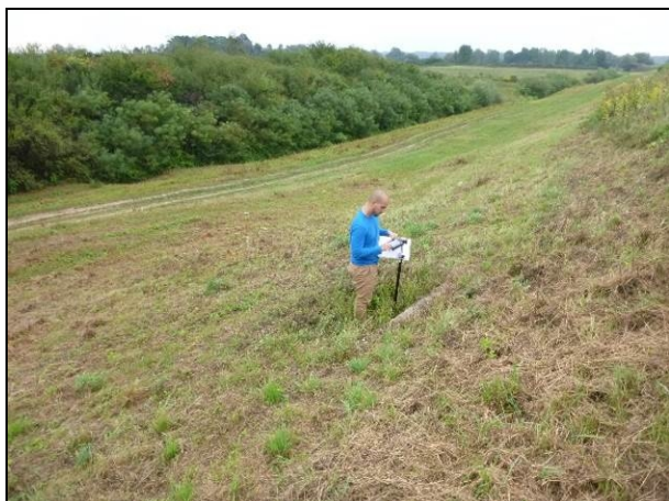
T 5: Udubina/slijeganje u donjem dijelu zaobalnog pokosa nasipa, dimenzija 2x2m i dubine 0,5 m
