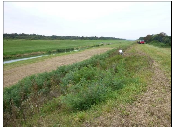
T 11: Niz od četiri klizišta na priobalnom pokosu nasipa. Klizanjem je zahvaćen pokos i dio kruna nasipa.
