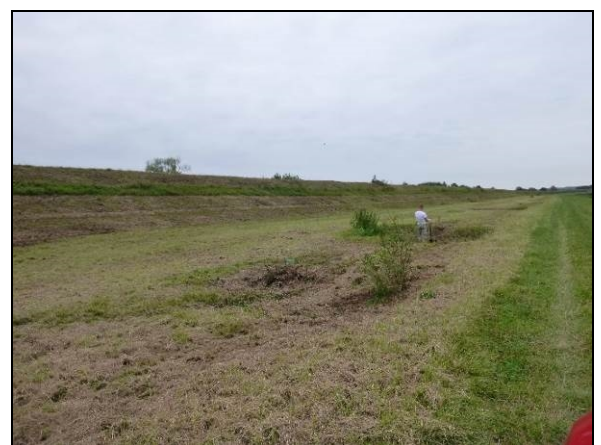
T 10: Slijeganja temeljnog tla (sufozije) u inundaciji. Pretpostavlja se da su antropogenog porijekla zbog pravilnog oblika i rasporeda.
