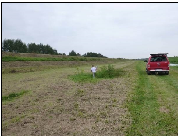
T 10: Slijeganja temeljnog tla (sufozije) u inundaciji. Pretpostavlja se da su antropogenog porijekla zbog pravilnog oblika i rasporeda.
