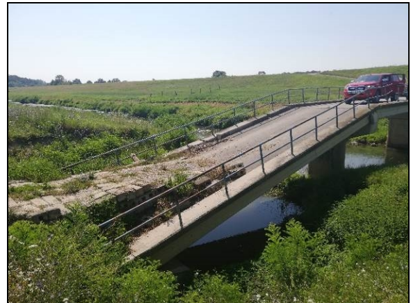
T 12: Odron u pokosu kanala uslijed čega je došlo do urušavanja temelja mosta. Odron je duljine 20 m i širine 30 m, sa skokom u čelu oko 3 m. Urušena je cijela jedna strana mosta što ugrožava siguran prijelaz preko mosta.
