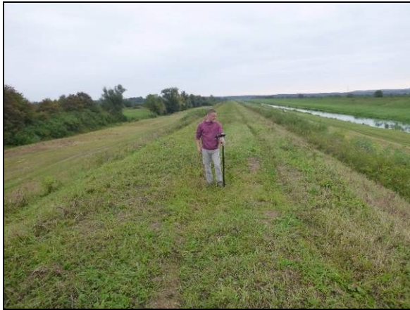
T 8: Pojave slijeganja u kruni nasipa dubine do 40 cm, na slici su vidljivi i kolotrazi uzrokovani djelovanjem vozila.
