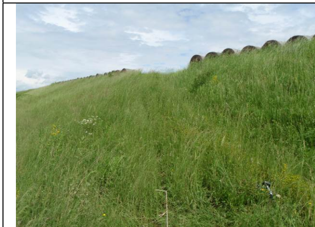
T 3: Rampa na priobalnoj strani tijela nasute građevine širine oko 2,5 m.
