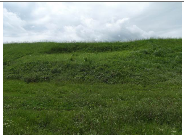
T 4: Klizište na zaobalnoj strani tijela nasute građevine površine 237 m 2 sa skokom u čelu od oko 2 m.
