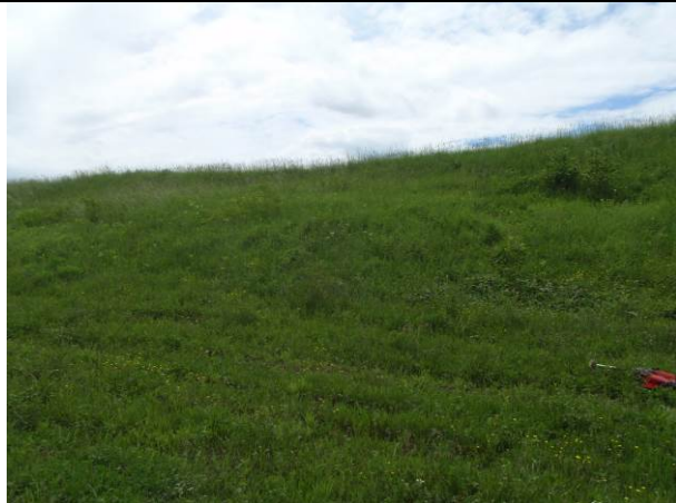
T 5: Klizište na zaobalnoj strani tijela nasute građevine površine 345 m 2 sa skokom u čelu od oko 1 m.
