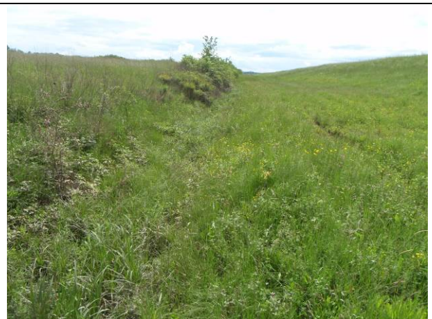
T 2: Drenažni kanal, u vrijeme kartiranja mjestimično registrirana voda visine stupca do procijenjeno 5 cm, širina dna oko 1 m, širina vrha oko 3, dubina oko 1 m.
