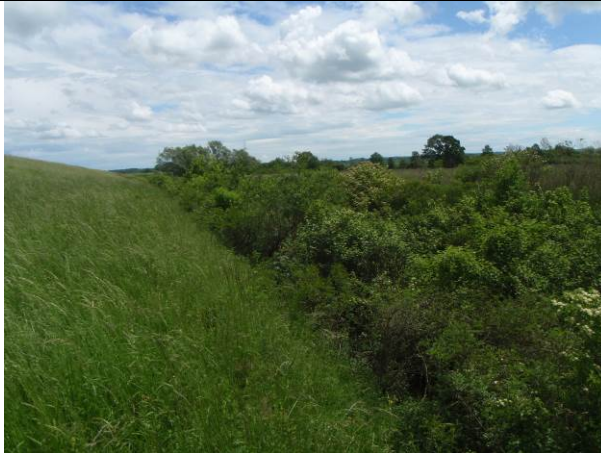
T 7: Drenažni kanal, u vrijeme kartiranja registrirana voda visine stupca do procijenjeno 20 cm, širina dna oko 3 m, širina vrha oko 7 m, dubina oko 3 m.
