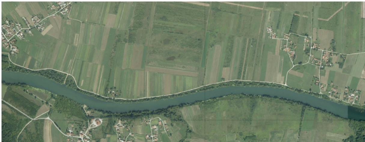
Slika 3.3: Situacija postojeće ceste
